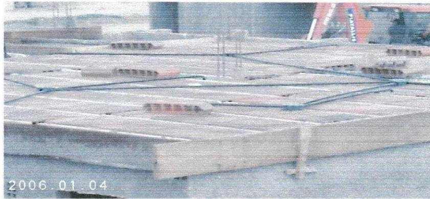
Foto 06 (Execução da laje)
