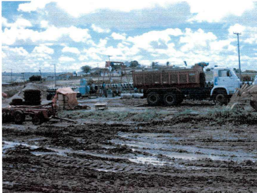
Figura 3 ( canteiro de obra)
