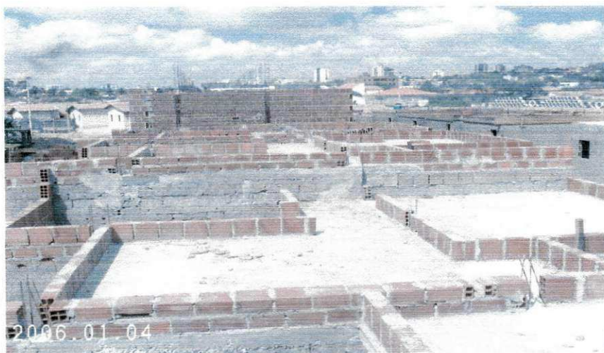
Foto 05 (Alvenaria de 1/2 vez)
