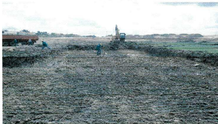
Foto 09 (Corte do terreno)
