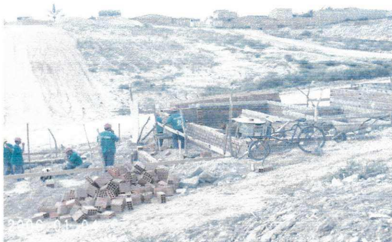
Foto 04 (Alvenaria de 1 vez + cinta)
