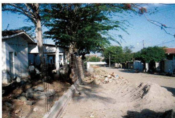
Figura 02 – Detalhe da construção do muro da Esc. Mun. Alice Gaudêncio.
