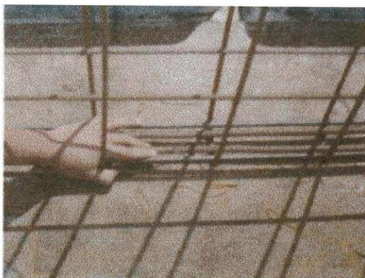
Figura 17 - Verificação dos espaçamentos das ferragens
