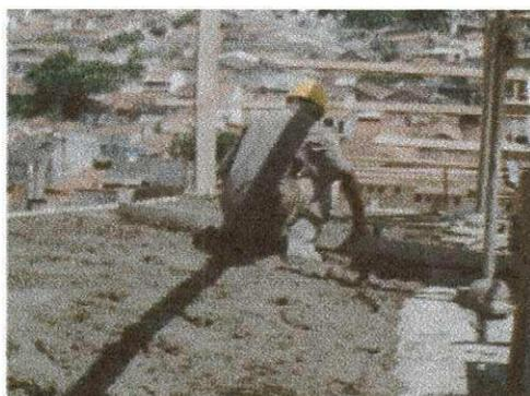
Figura 12 - Nivelamento do concreto
