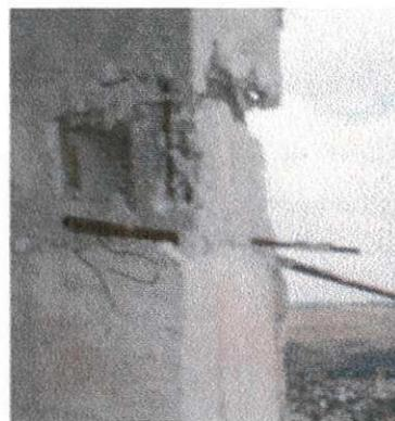
Figura 22 - Segregação de concreto e exposição da armadura
