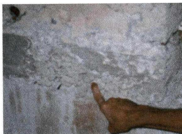
**Figura 25 - Falhas no pilar**
