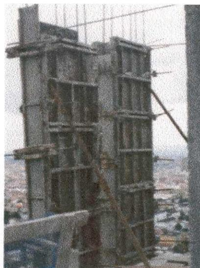
Figura 18 - Armadura à espera do concreto usinado
