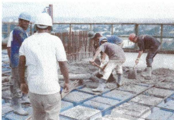
Figura 9 - Lançamento do concreto usinado
