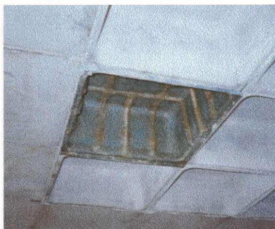
Figura 14 - Laje nervura após a concretagem, faltando retirar uma cumbuca, vista de baixo para cima
