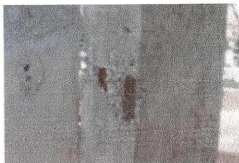
**Figura 24 - Segregação de concreto e exposição da armadura**
