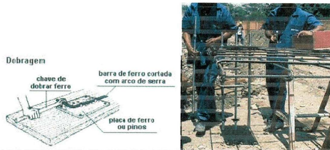
Figura 07 – Montagem das ferragens das sapatas.
