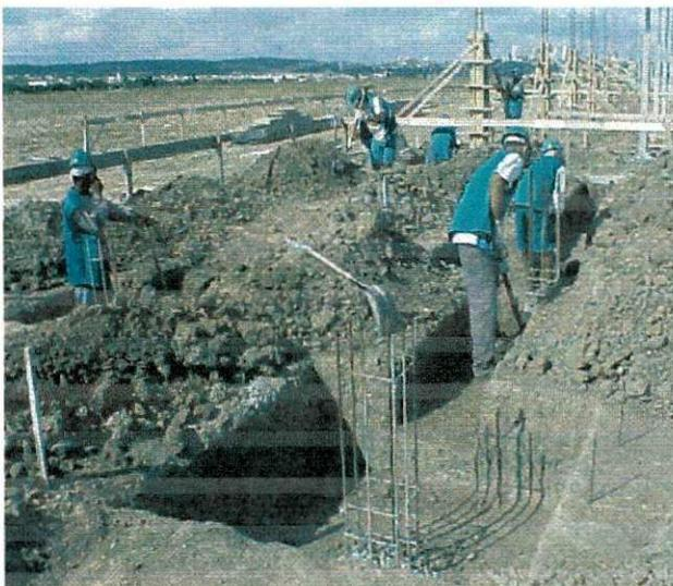
fig.10-aterro das sapatas
