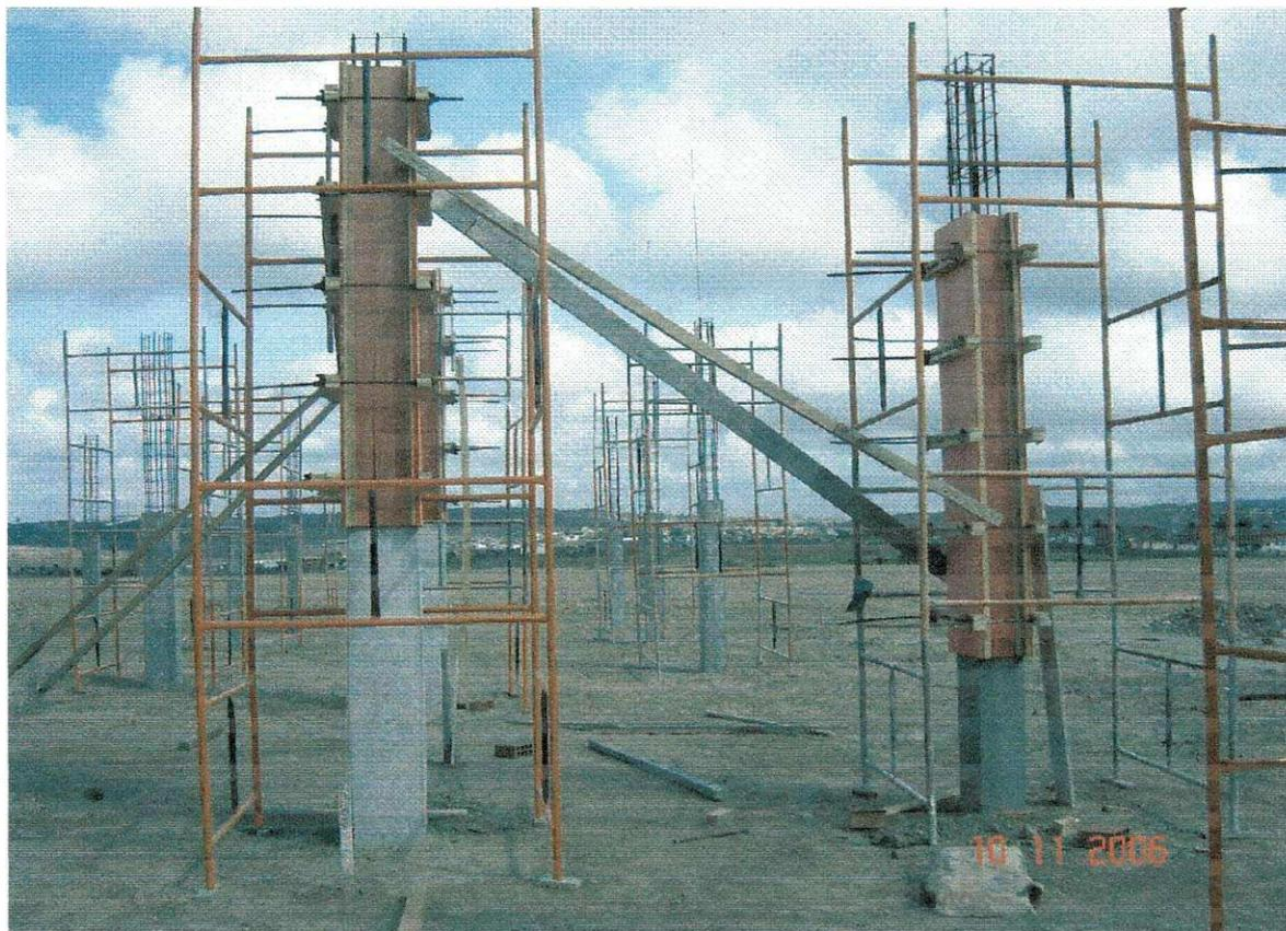
fig.16. segunda parte do concreto
