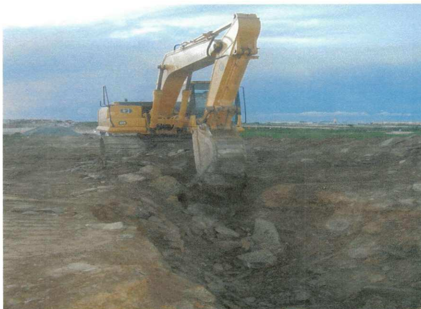
Figura 5: Escavação feita com a PC
