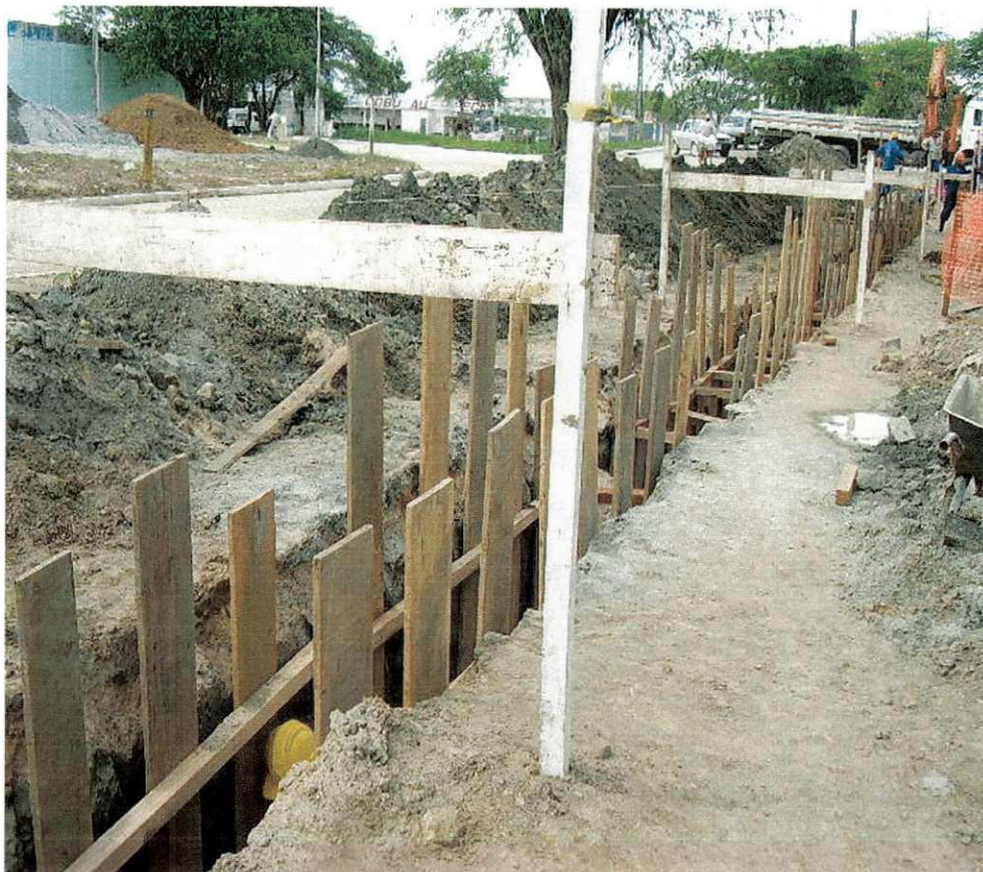
Figura 8: Escoramento descontinuo
