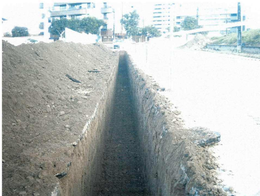
Figura 3: Material depositado de um só lado da vala
