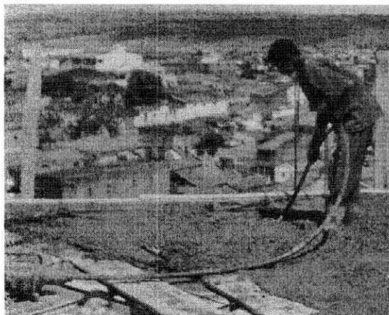
Figura 6-Operário vibrando o concreto.
