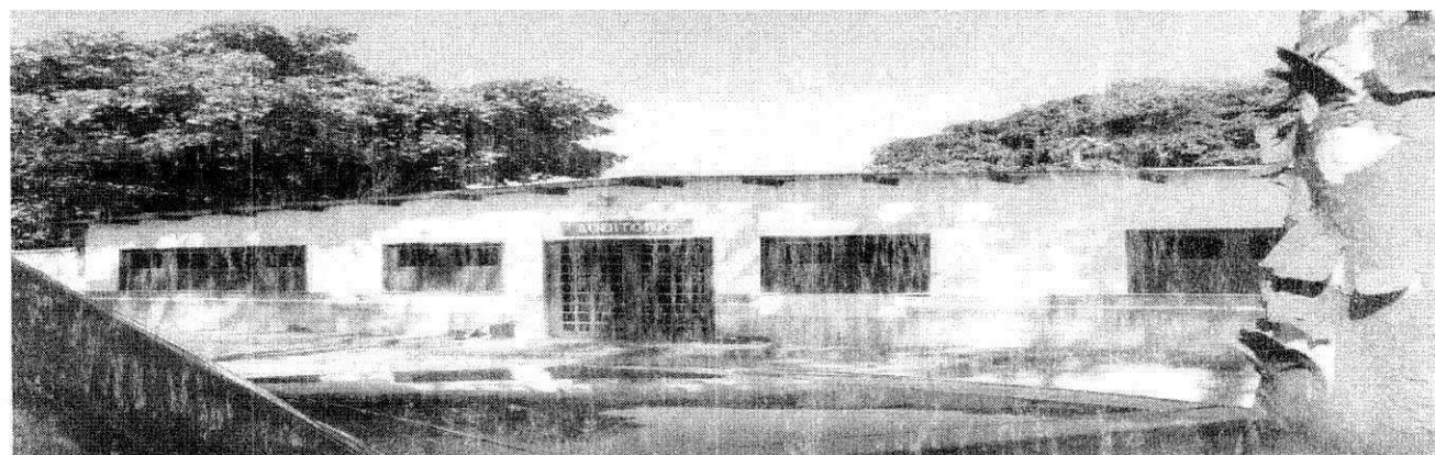
Figura 18 – Auditório localizado no canteiro de obras central.
