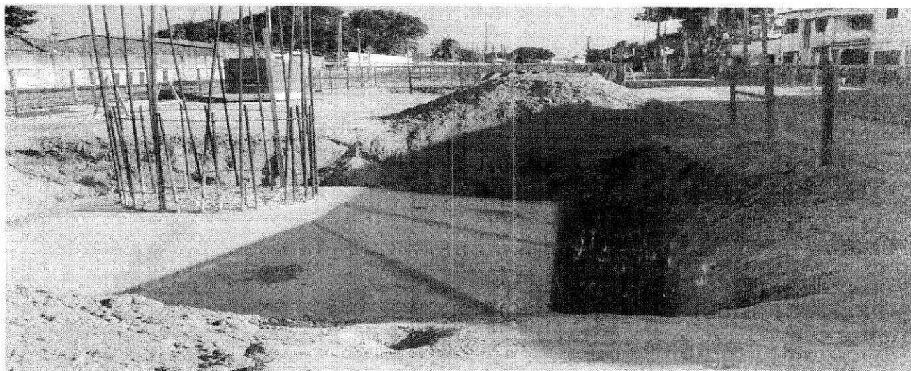
Figura 16 – Blocos de concreto armado com espera.
