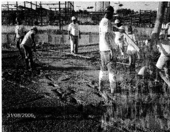
Figura 4-Operários lançando o concreto
