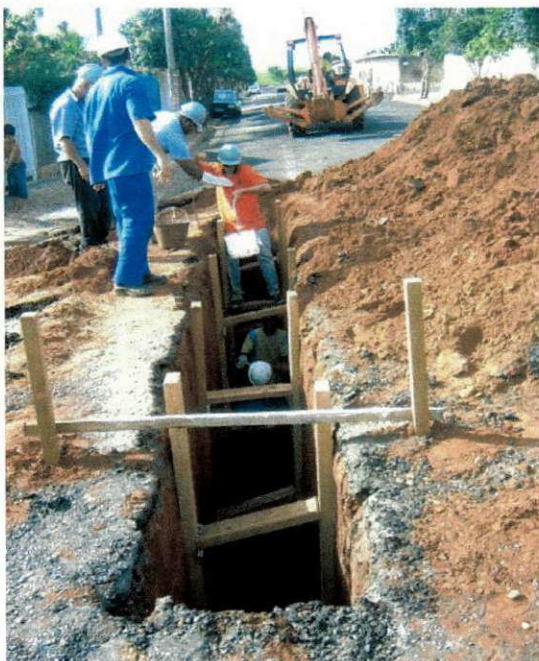
Foto 4 – 5 : Instalação de rede de esgoto.
