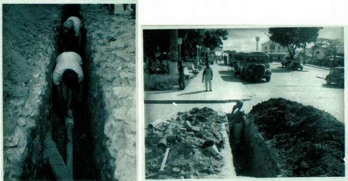
Foto: 1 – 2 : Implantação de rede de abastecimento de água.(ano 1967)
