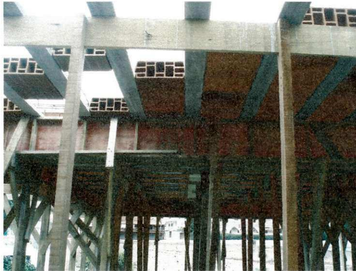
Figura 12 – Posicionamento das Lajotas.
