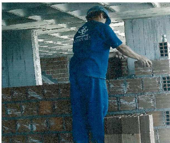
Figura 14 – Alvenaria nos apartamentos.
