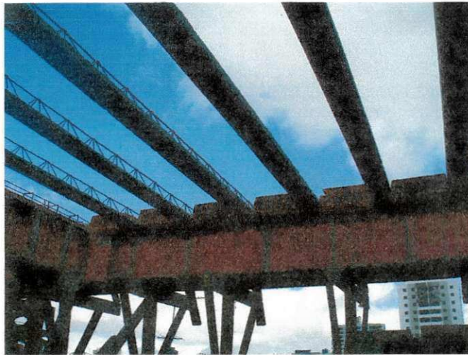
Figura 10 – Encaixe das treliças.
