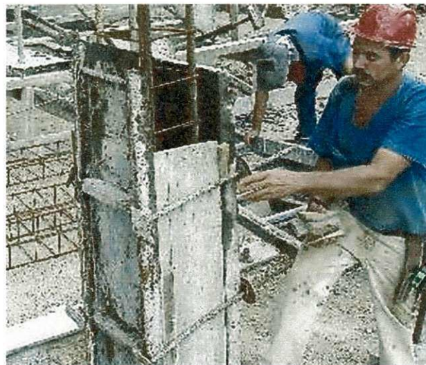
Figura 09 – Preparo da fôrma do pilar para concretagem.
