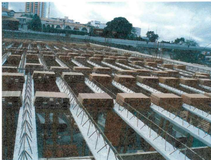
Figura 11 – Posicionamento das Lajotas para correto espaçamento das treliças.
