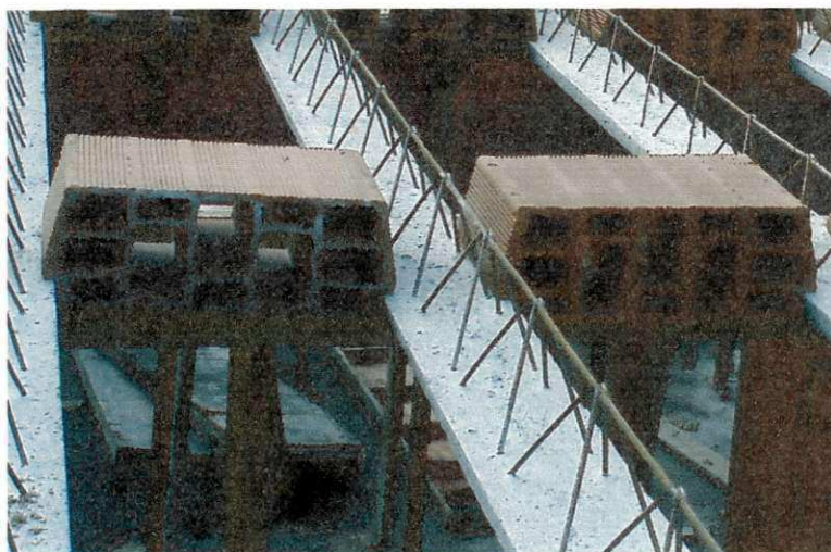
Figura 05 – Bloco para laje pré-moldada
