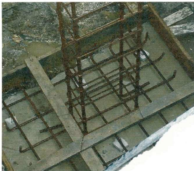
Figura 06 – Armadura e fôrma para sapata.
