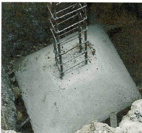
Figura 08 – Sapata pronta.
