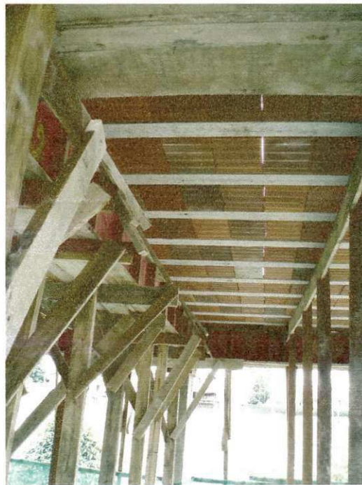
Figura 13 – Escoras para apoio das treliças.
