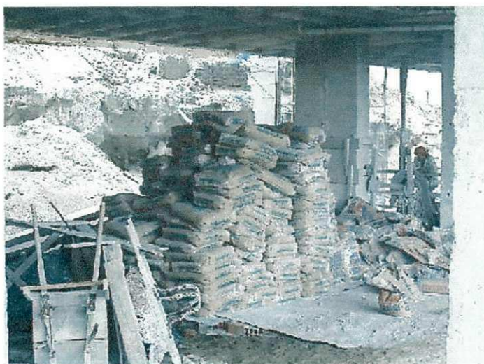
Figura 03 – Material estocado em local onde será a garagem.
