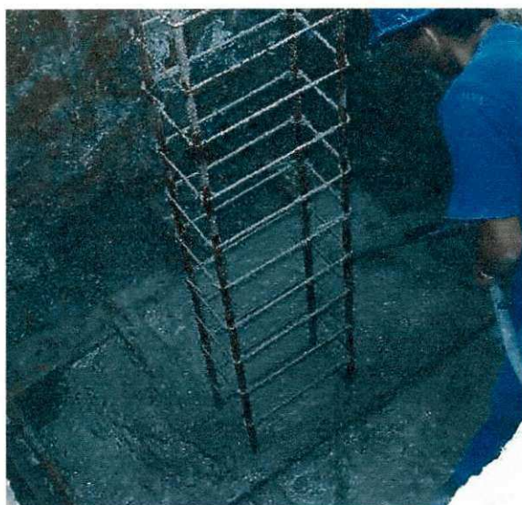
Figura 07 – Armadura e fôrma para sapata.
