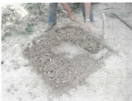
Figura 5.1 Remoção do material não representativo do subleito
