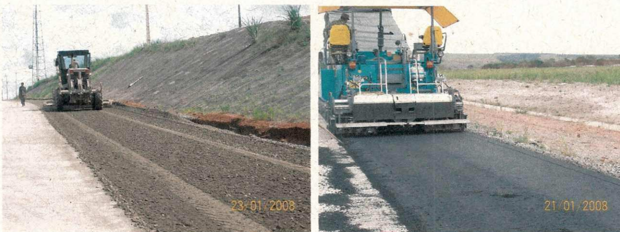
Figura 10 – execução do acostamento
