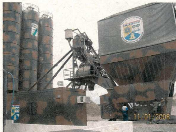
Figura 7 – preparação do concreto na usina do 2º BEC
