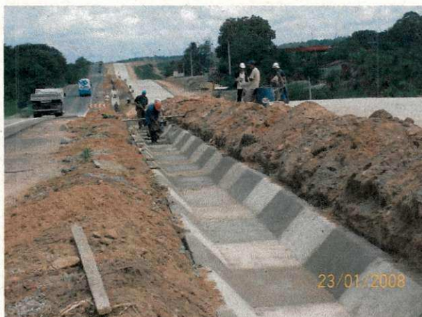
Figura 11 – sarjeta de canteiro central
