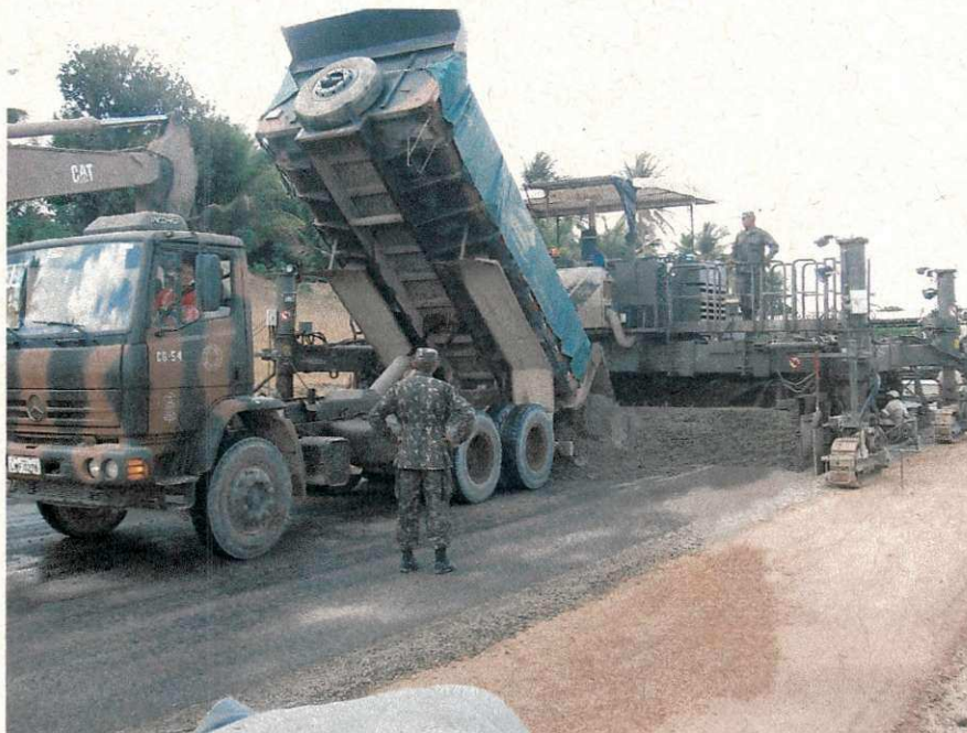
Figura 8 – descarregamento do concreto
