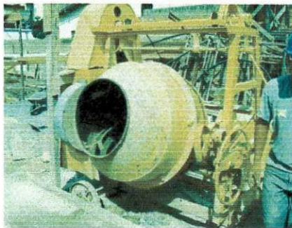
Figura 2.7 – Preparação do concreto na betoneira
