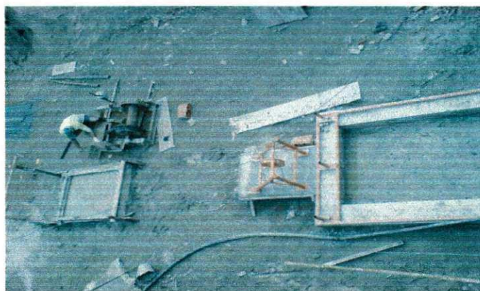
Figura 4.28 – Montagem do elevador
