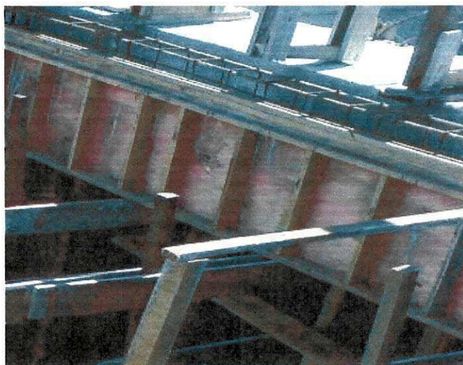
Figura 4.15 – Painéis das vigas com sarrafos transversais
