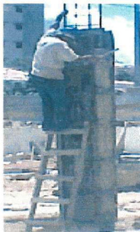
Figura 2.8 - Retirada da fôrma de um pilar.
