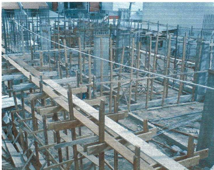
Figura 4.14 – escoramento tipo cavalete
