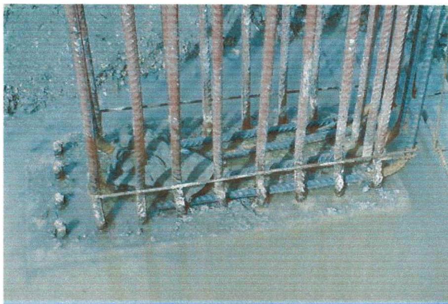
Figura 4.2 - Corte e adição de ferro no pilar
