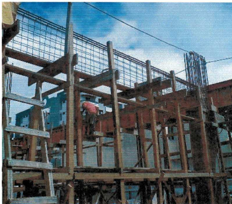
Figura 4.12 - Armadura da viga.
