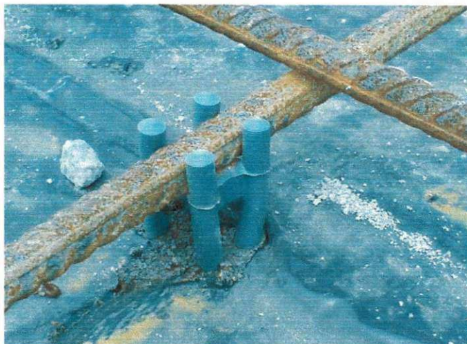
Figura 22– Espaçadores para lajes
