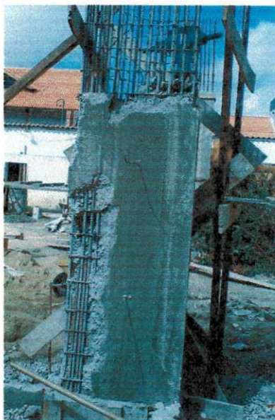
Figura 4.11– Demolição do pilar
