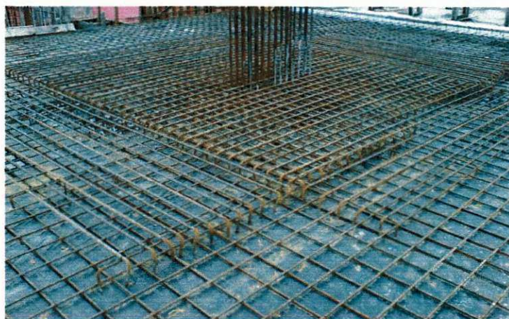
Figura 4.21 - Armadura negativa
