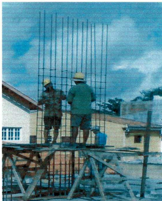
Figura 4.4 - Armação do pilar
