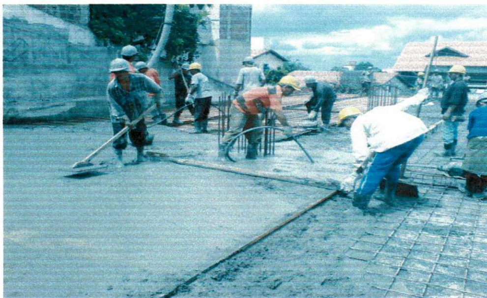
Figura 4.26 – Concretagem de lajes e vigas
