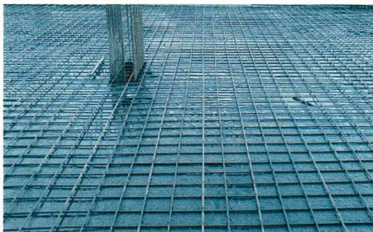
Figura 4.20 - Armadura positiva
