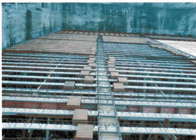
Figura 4.23 – Montagem da laje pré-fabricada
