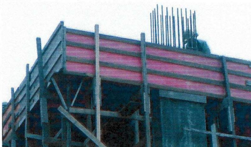
Figura 4.17 – Painéis das vigas com sarrafos longitudinais
