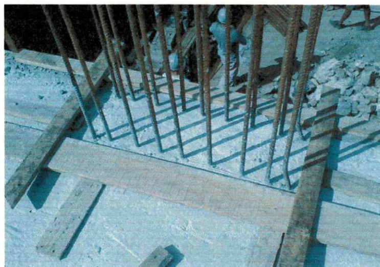
Figura 4.3 – Engastamento da fôrma
