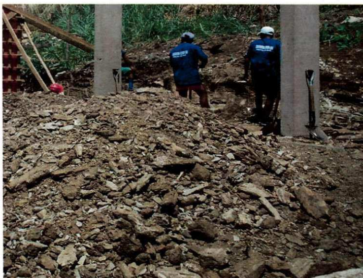
Figura 5.2: Aterro após concretagem das vigas baldrame
