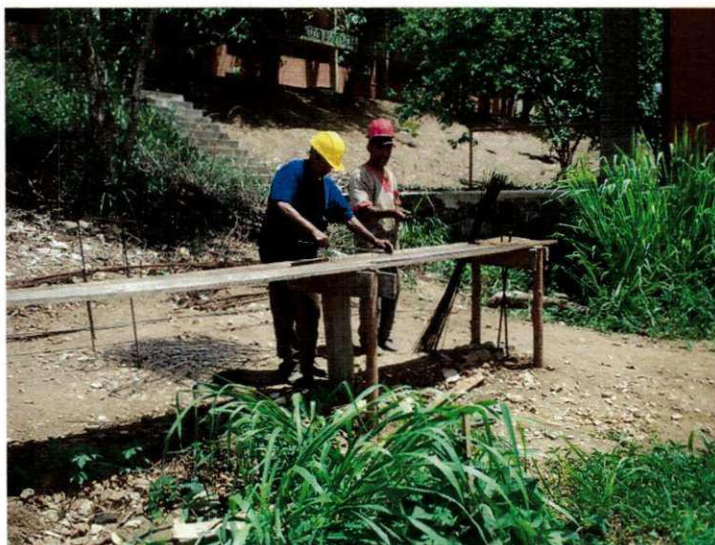
Figura 5.5: Preparação e montagem das ferragens
