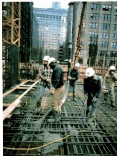
Figura 3.6: Lançamento do concreto sobre as armaduras
