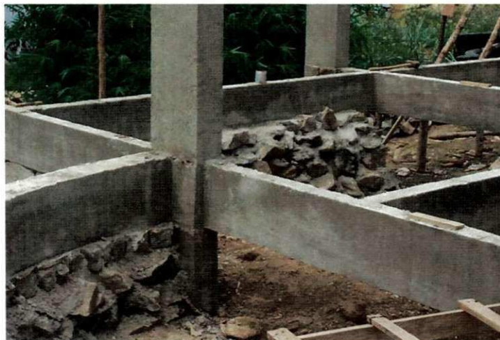
Figura 5.3: Estrutura de contenção para o aterro interno
