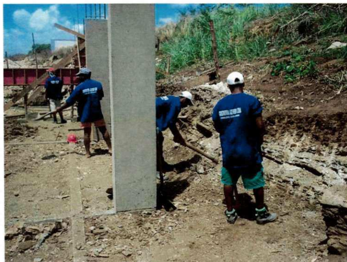
Figura 5.1: Escavação do direito de 3 m sob terreno inclinado
