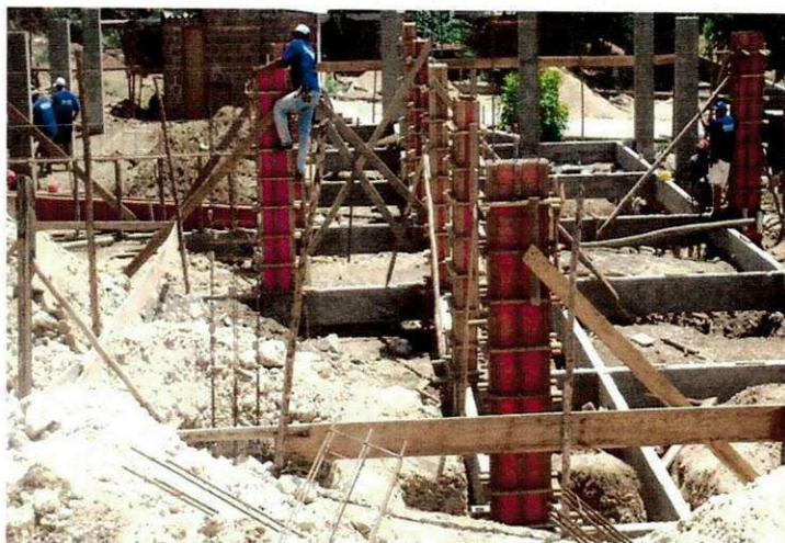
Figura 5.6: Montagem das fôrmas dos pilares
