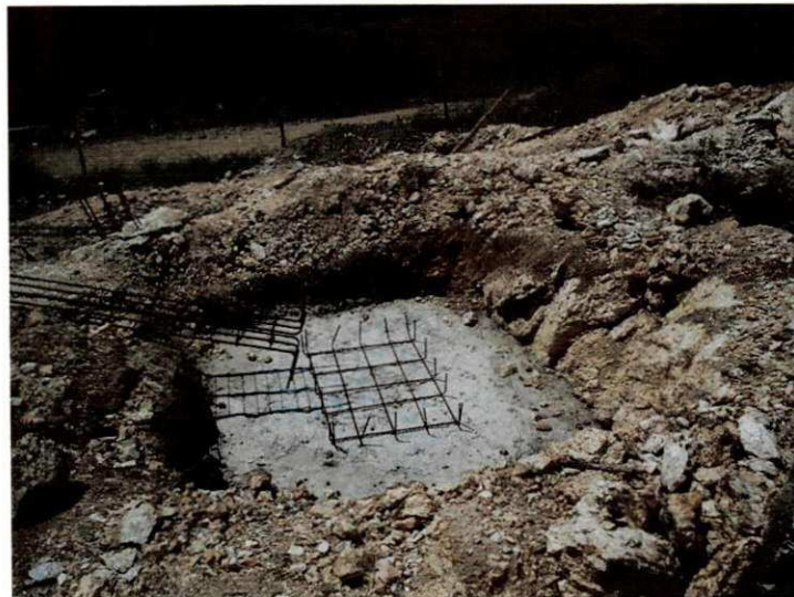
Figura 5.9: Sapata concretada e montagem do fuste.
