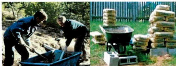
Figura 3.5: Métodos e materiais para a mistura do concreto virado em obra
