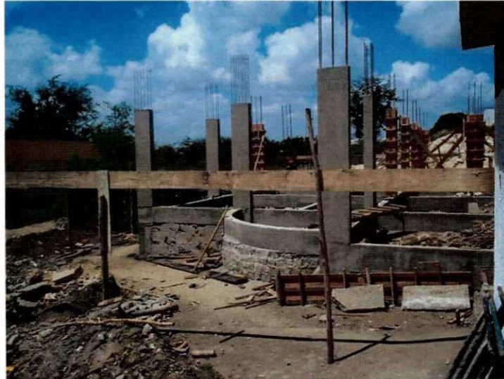
Figura 5.8: Remoção da fôrmas dos pilares
