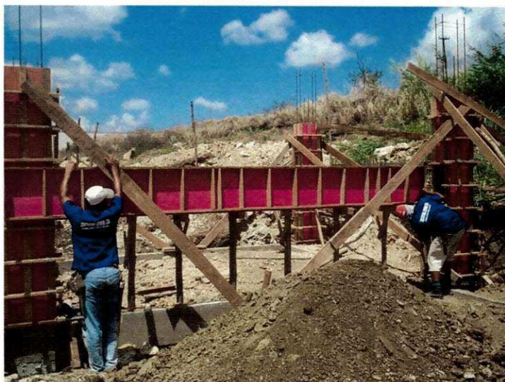
Figura 5.7: Assentamento das fôrmas da viga inferior da escada
