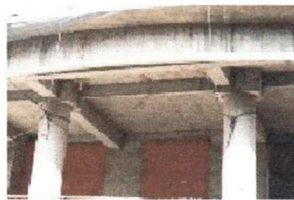
Figura 7.2.1.b Laje maciça e blocos de transição
