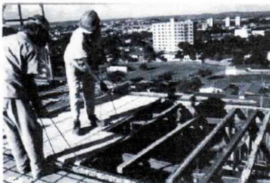
Fig 7.2.1.c Colocação dos elementos pré-moldados
