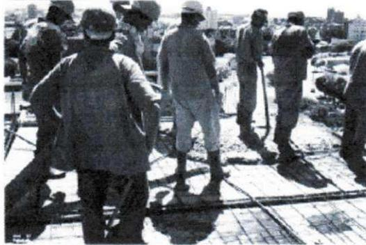
Fig. 7.2.1.d Lançamento do concreto
