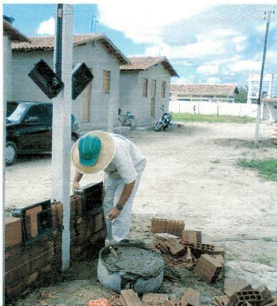
Figura 6 - Marcação e assentamento da alvenaria
