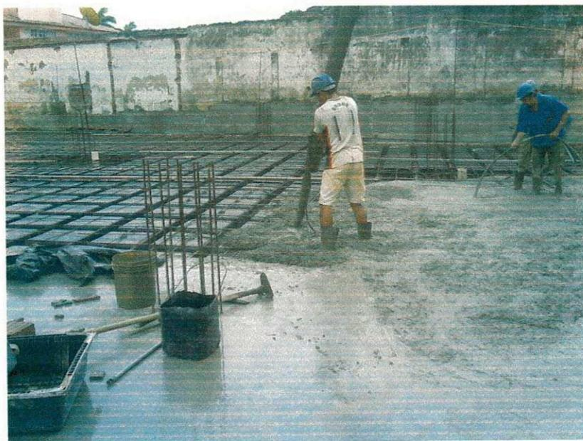
**Foto A1 : Concretagem da laje**
