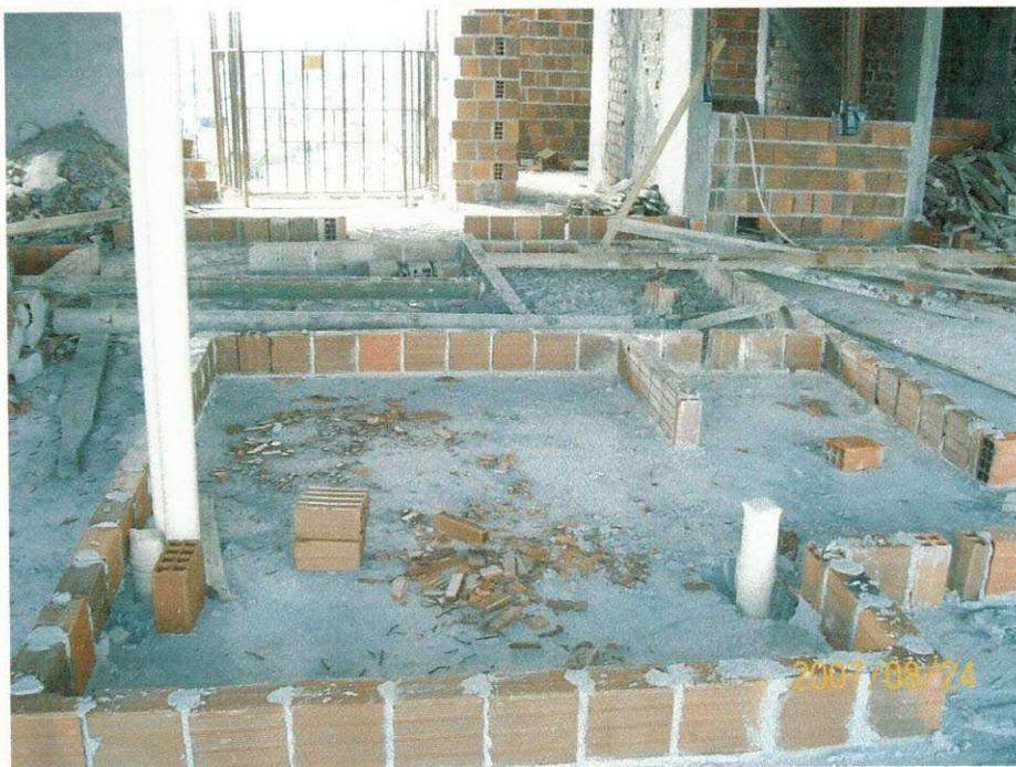
**Foto A7.** Levantamento de alvenaria.
