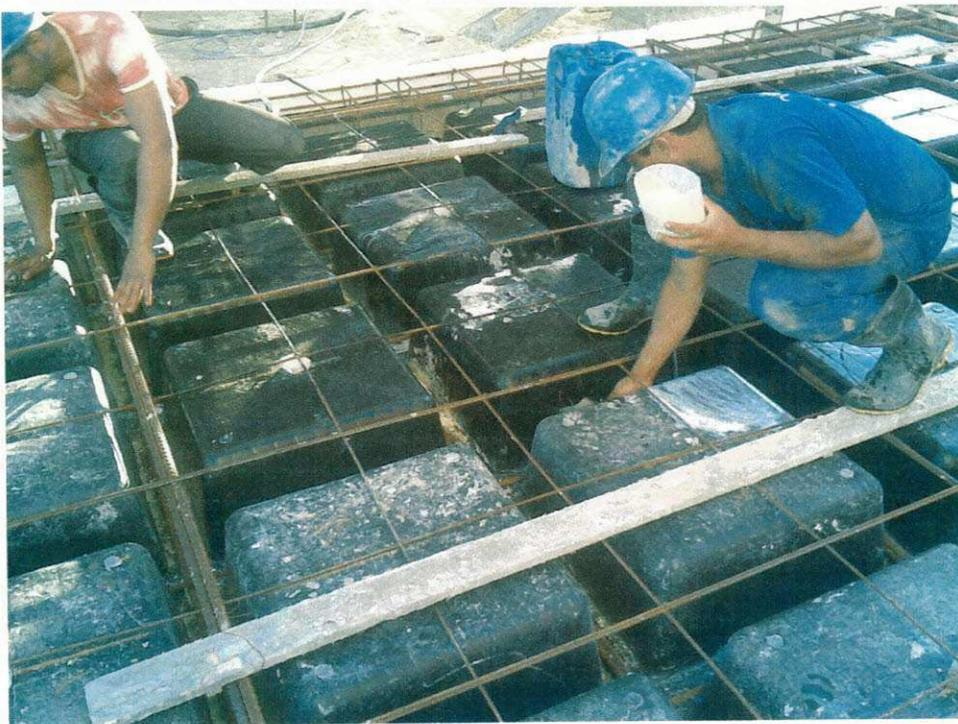
**Foto A4 : Aplicação do desmoldante**
