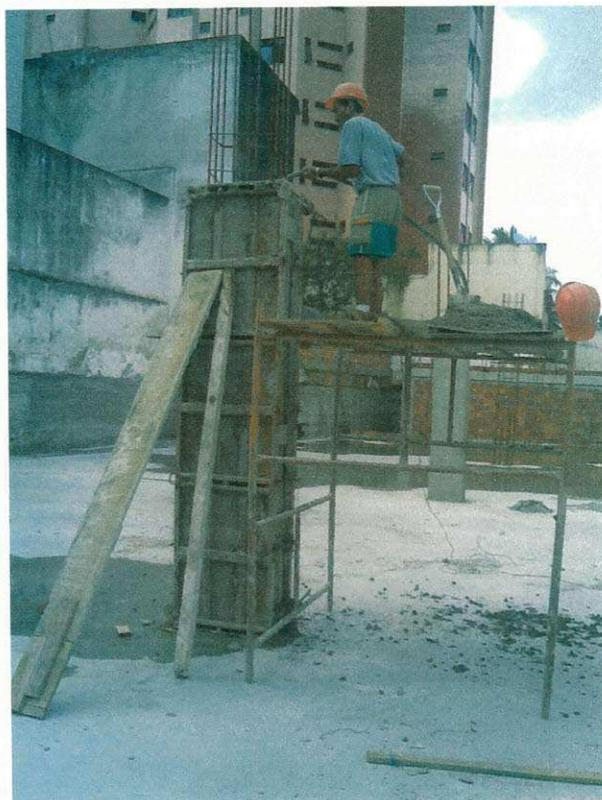
**Foto A6 : Concretagem do pilar**
