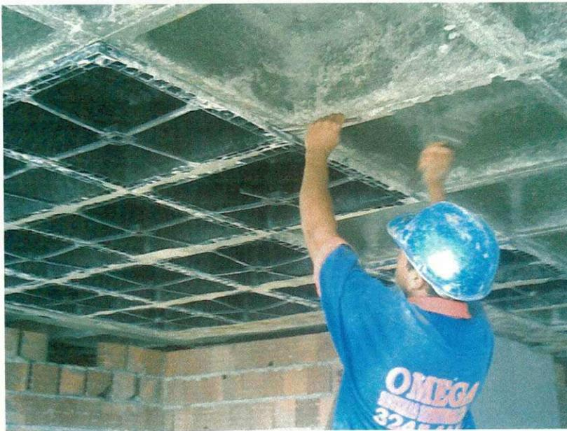
**Foto A5 : Desforma das lajes**
