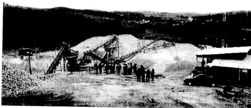
Figura 12 – Pedreira em Atividade Produzindo Materiais para Execução de Base de Brita Graduada
