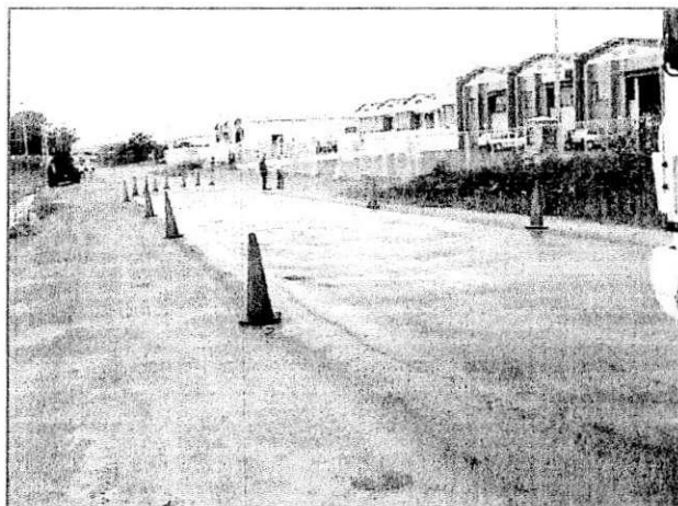
Figura 27 - Pintura de Ligação em Restauração
