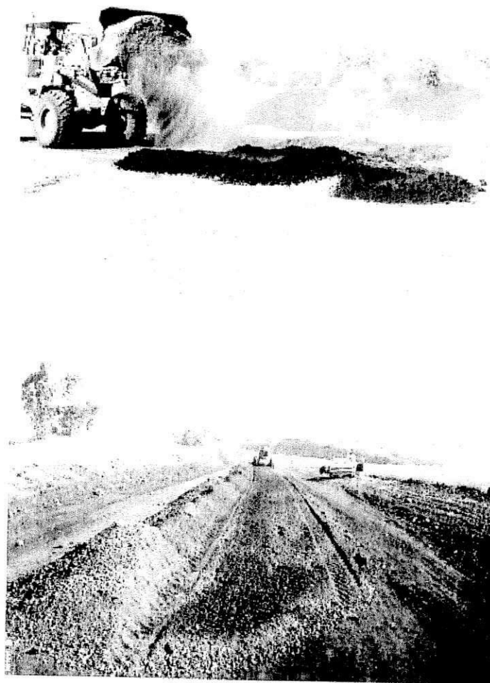
Figura 13 – Preparação e Execução de Trecho em Solo-Brita
