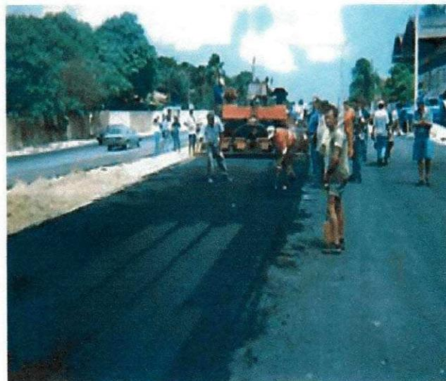
(b) Revestimento asfáltico sendo executado
