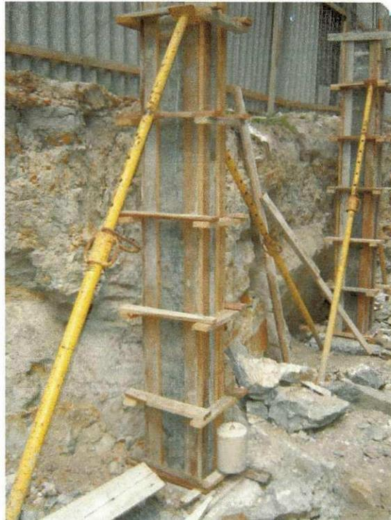
**Figura 1.** Fôrma de madeira para pilar
