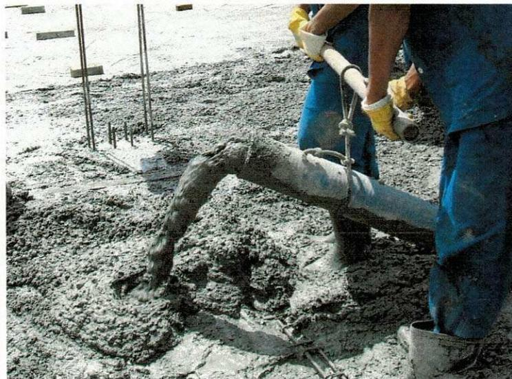
**Figura 4.** Lançamento do concreto usinado
