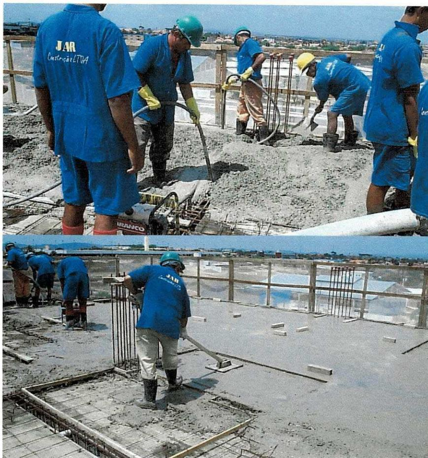
**Figura 9.** Concretagem de lajes e vigas (Pinheiro, 2006).
