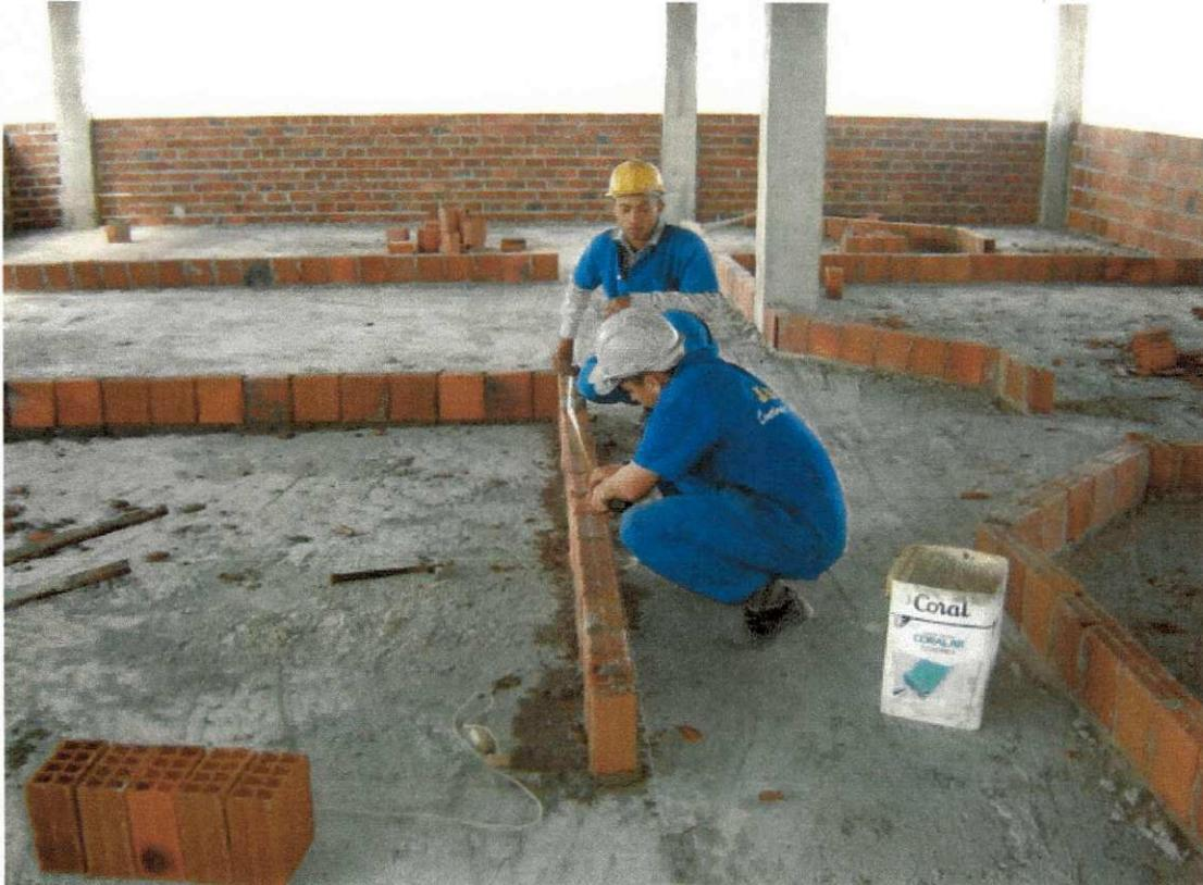
**Figura 12.** Detalhes dos processos de marcação e levantamento de alvenaria.
