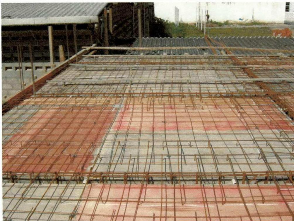
**Figura 7.** Detalhe das armaduras das lajes e vigas.
