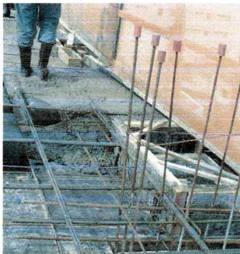
**Figura 4.10- Concretagem de vigas**
