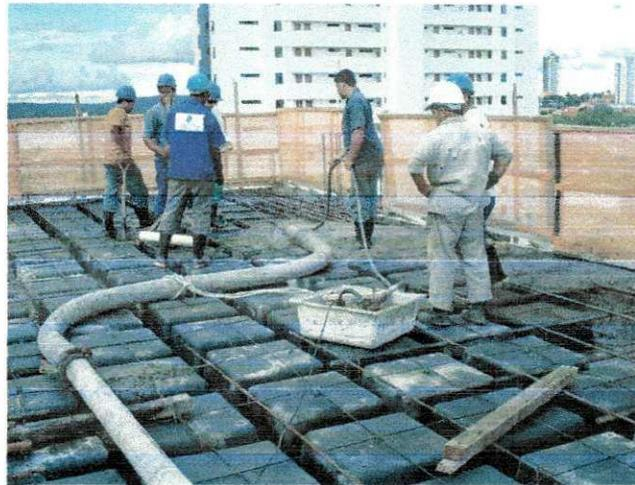
**Figura 4.8- Adensamento do concreto**
