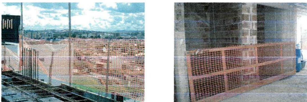
**Figura 5.2 – Plataforma de proteção**
