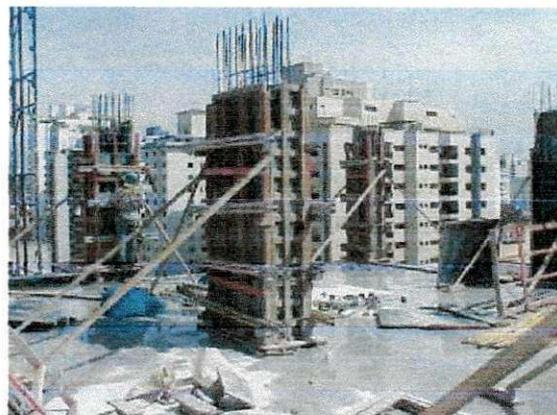
**Figura 4.6 – Contraventamento em pilares**
