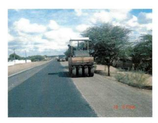
Figura 3.10 Exemplo de compactação de agregado.
