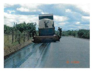
Figura 3.9 Exemplo de distribuição da 1ª camada de agregado.
