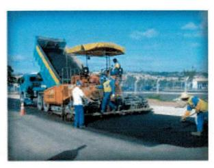
Figura 3.2 Exemplo de lançamento de C.B.U.Q em vibroacabadora.
