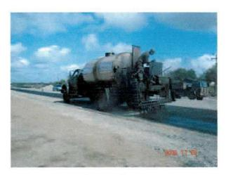
Figura 3.1 Exemplo de aplicação de imprimação.
