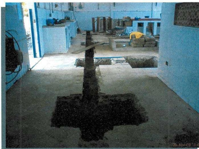
Figura 4 - Escavação das valas para as sapatas
