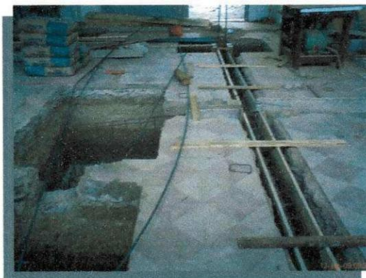
**Figura 9 - Suspensão da viga baldrame**
