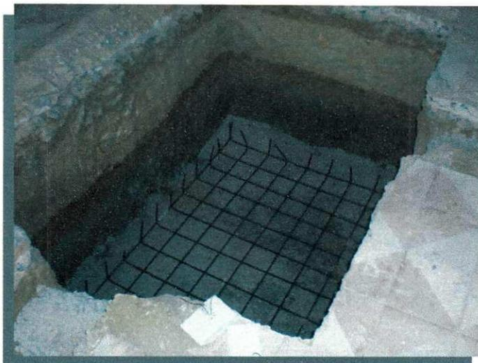
**Figura 5 - Regularização da sapata**
