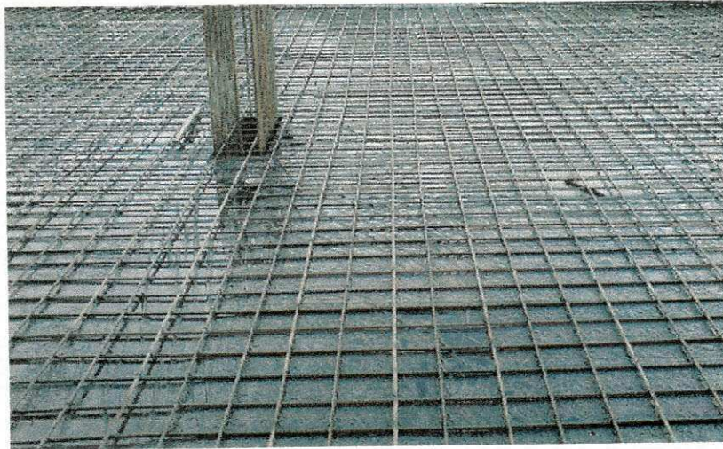
Figura 4.19 - Armadura positiva
