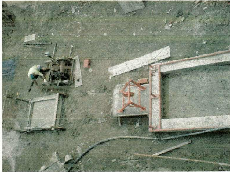
Figura 4.27 – Montagem do elevador
