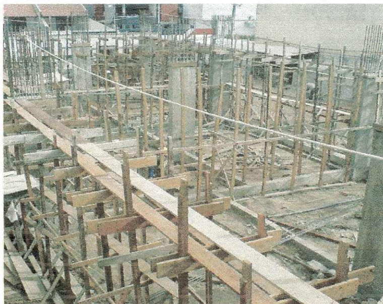
Figura 4.13 – escoramento tipo cavalete
