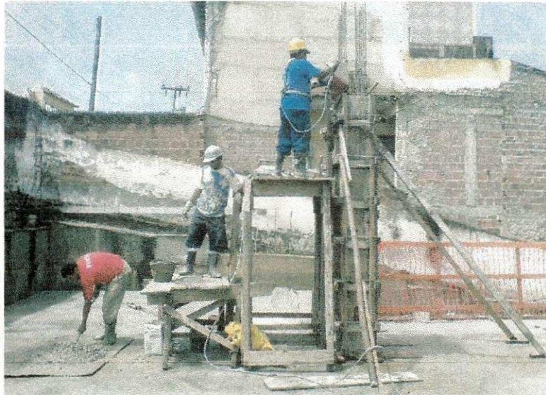
Figura 4.6 – concretagem do pilar
