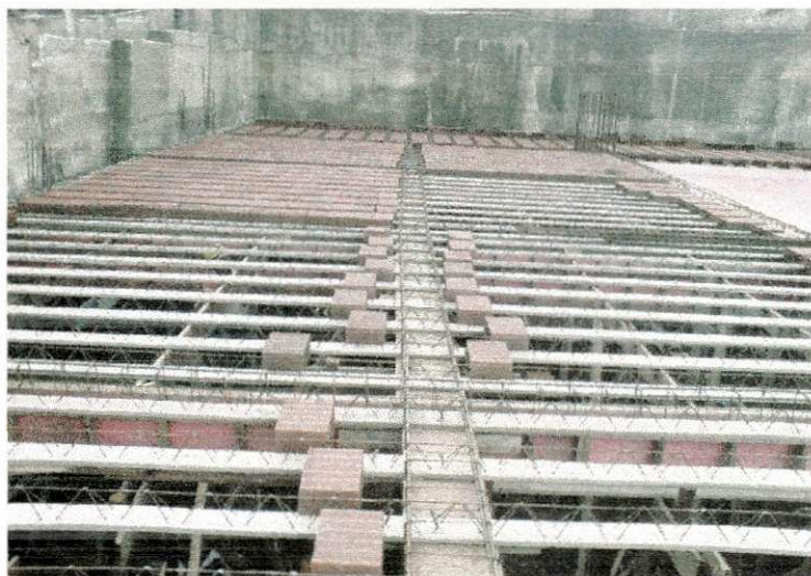
Figura 4.22 – Montagem da laje pré-fabricada
