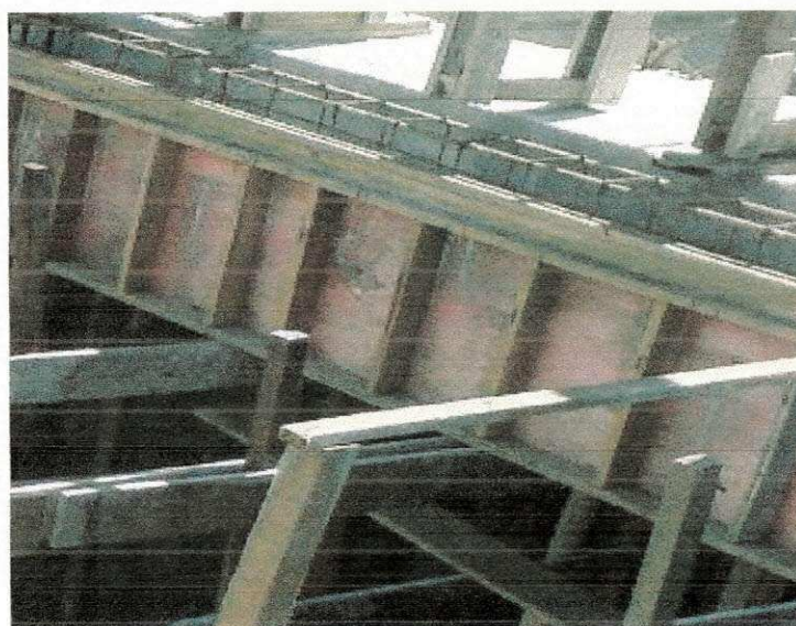
Figura 4.14 – Painéis das vigas com sarrafos transversais
