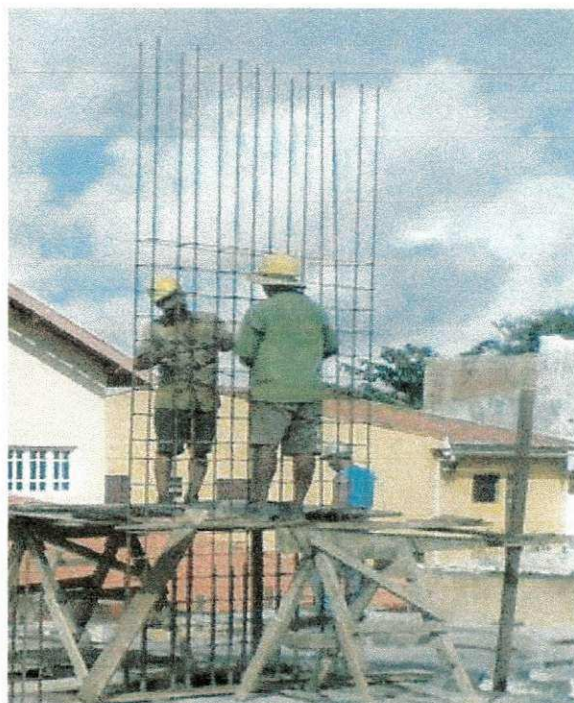
Figura 4.4 - Armação do pilar
