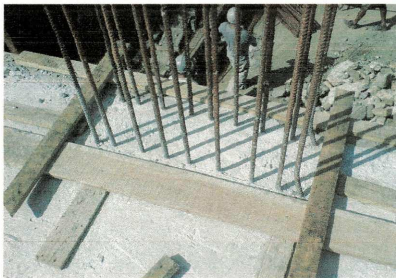
Figura 4.3 – Engastamento da fôrma
