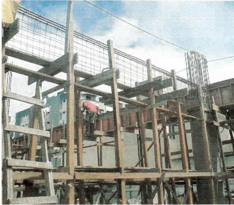
Figura 4.11 - Armadura da viga.
