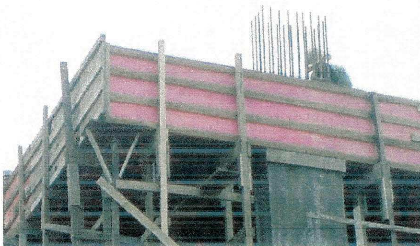
Figura 4.16 – Painéis das vigas com sarrafos longitudinais
