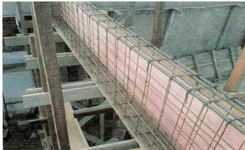
Figura 4.12 – viga com painel lateral
