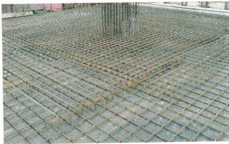
Figura 4.20 - Armadura negativa
