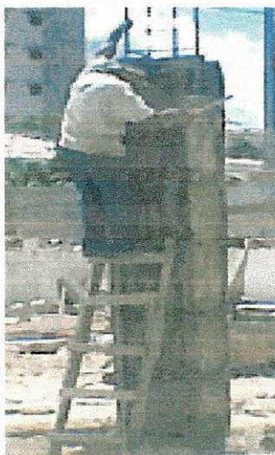
Figura 2.8.- Retirada da fôrma de um pilar.
