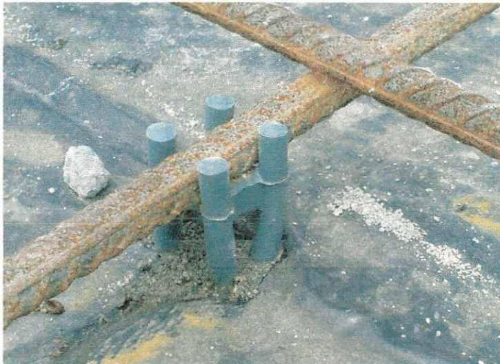
Figura 21– Espaçadores para lajes
