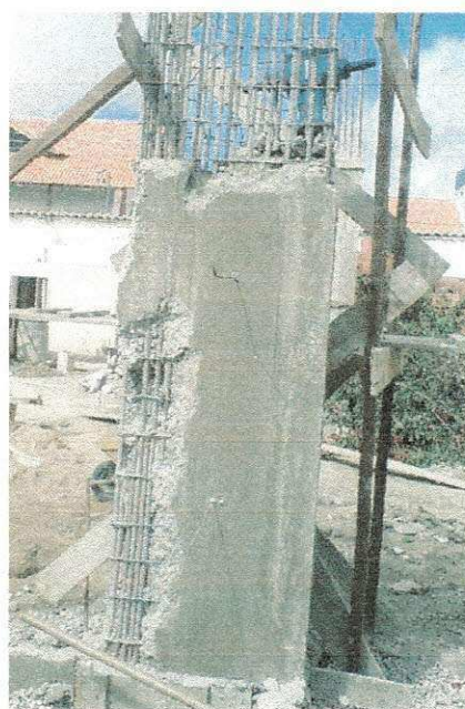
Figura 4.10– Demolição do pilar
