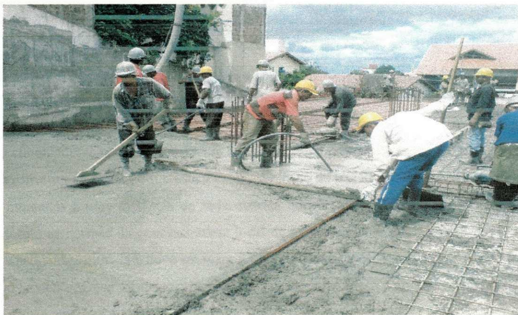
Figura 4.25 – Concretagem de lajes e vigas
