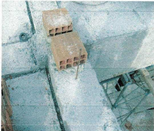
FOTO 85: ALVENARIA DE 1 VEZ
