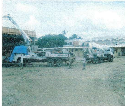
FOTO 84: CARRO BETONEIRA COM BOMBA
