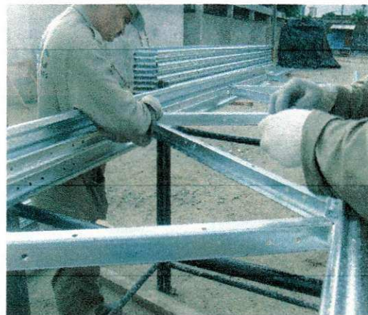
FOTO 93: MONTAGEM DA TRELIÇA
