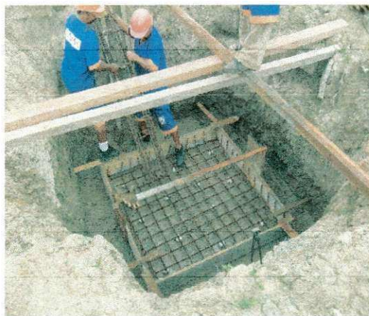
FOTO 20: LOCAÇÃO DA FERRAGEM DO PILAR
