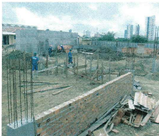
FOTO 45: EMBASAMENTO SOBRE A FUNDAÇÃO
