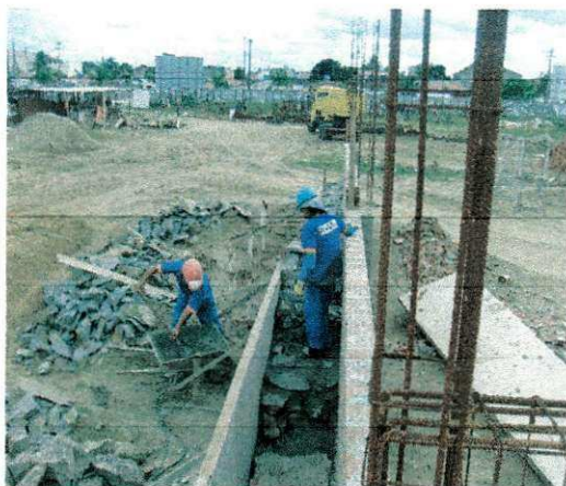
FOTO 28: EXECUÇÃO DO MURO
