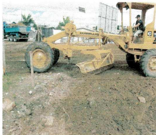
FOTO 12: NIVELAMENTO DO MATERIAL
