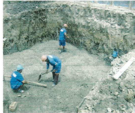
FOTO 72: NIVELAMENTO COM O CONCRETO MAGRO
