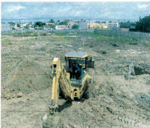
FOTO 16: ESCAVAÇÃO DAS VALAS
