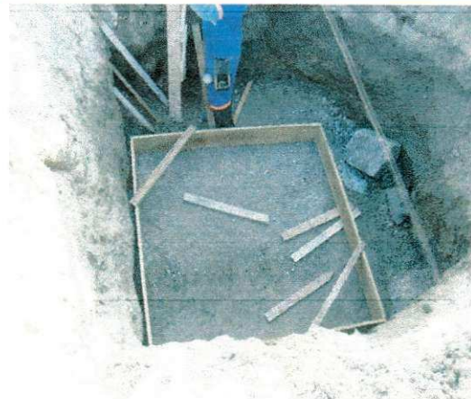
FOTO 19: FORMA DA FUNDAÇÃO
