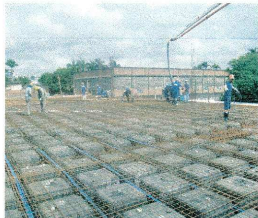
FOTO 65: LANÇAMENTO DO CONCRETO
