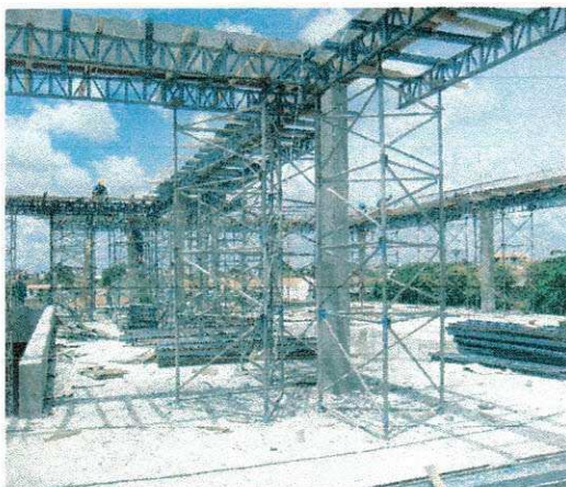
FOTO 39: TORRES DE ESCORAMENTO
