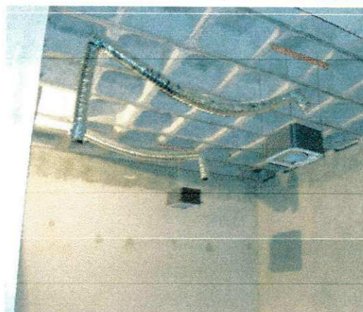
FOTO 109: DUTOS FLEXÍVEIS E FANCOLETES
