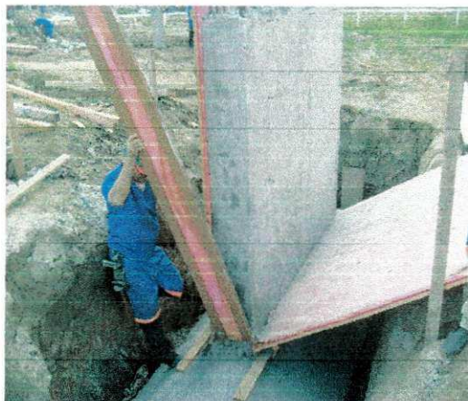
FOTO 36: DESFORMA DO PILAR
