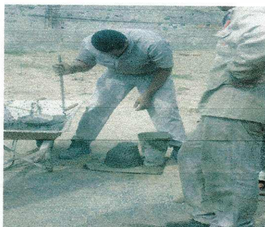
FOTO 82: MEDIÇÃO DO SLUMP
