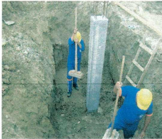
FOTO 25: ATERRAMENTO DA SAPATA
