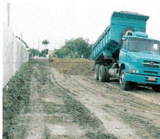
FOTO 10: MATERIAL PARA NIVELAMENTO
