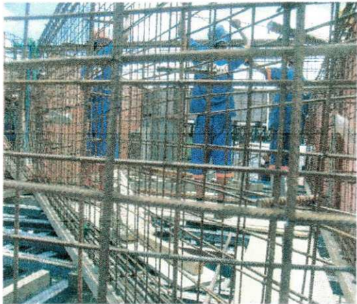
FOTO 52: ARMAÇÃO DA FERRAGEM
