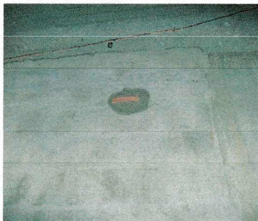
FOTO 96: MARCAÇÃO DA ESPESSURA
