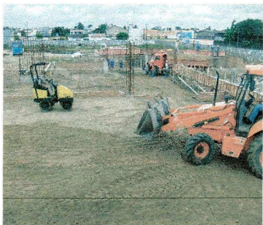
FOTO 13: ATERRO PARA NIVELAMENTO
