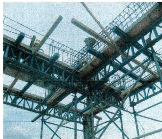
FOTO 40: TRELIÇAS DE ESCORAMENTO
