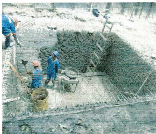
FOTO 74: REVESTIMENTO DO RESERVATÓRIO
