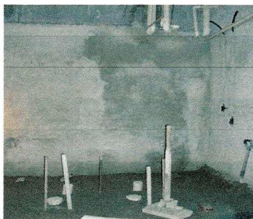
FOTO 103: PONTOS DA REDE DE ESGOTO
