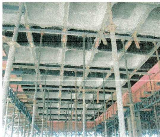
FOTO 69: VAZIOS DA LAJE NERVURADA
