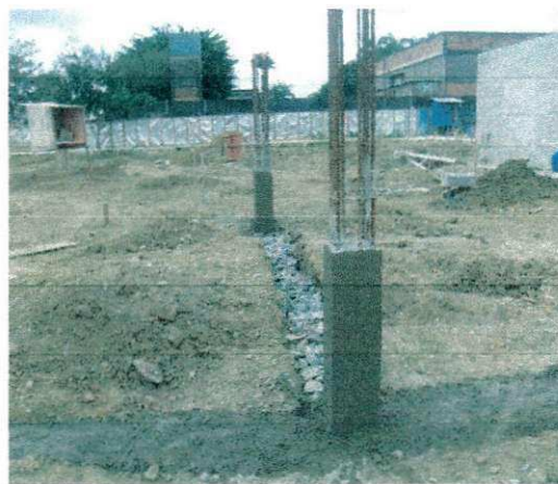
FOTO 44: FUNDAÇÃO EM PEDRA GRANÍTICA
