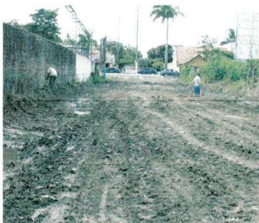
FOTO 9: LIMPEZA DO TERRENO
