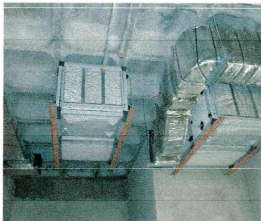
FOTO 108: DUTOS COM CHAPA GALVANIZADA E FANCOIS
