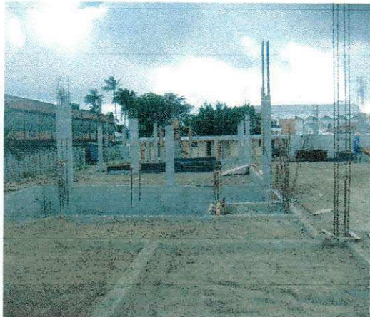
FOTO 37: PILARES COM ESPERAS
