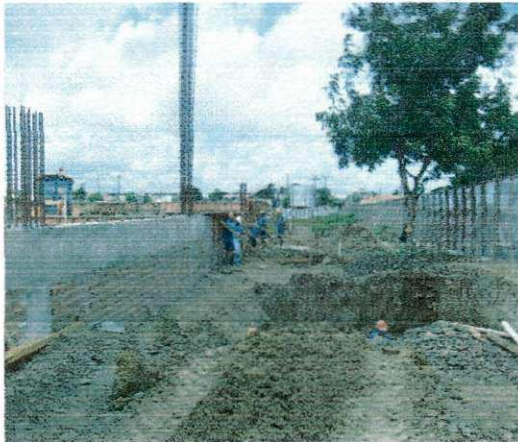
FOTO 71: ESCAVAÇÃO DO RESERVATÓRIO
