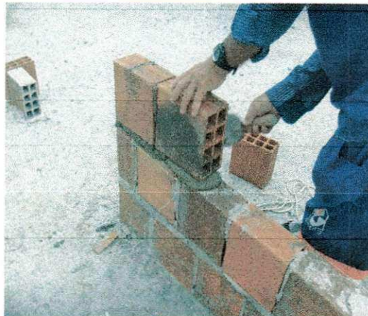
FOTO 91: EXECUÇÃO DA ALVENARIA
