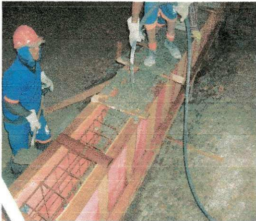
FOTO 48: LANÇAMENTO DO CONCRETO
