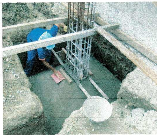
FOTO 24: ACABAMENTO DA SAPATA
