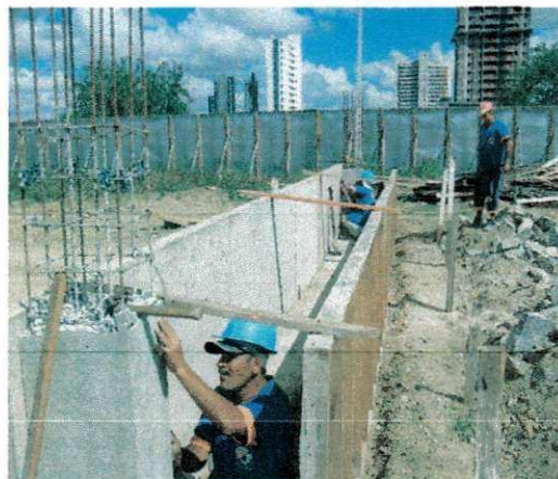
FOTO 27: LOCAÇÃO DO MURO
