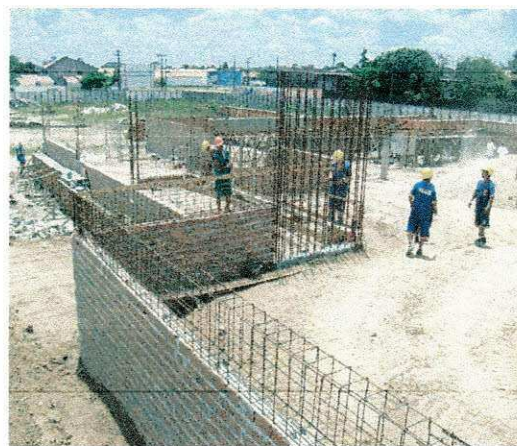
FOTO 14: ALVENARIA DE EMBASAMENTO
