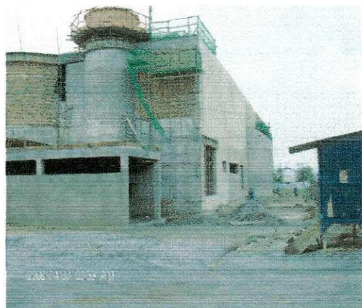
FOTO 76: FORMA E ESCORAMENTO DO RESERVATÓRIO
