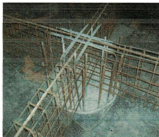
FOTO 77: VIGAMENTO DO RESERVATÓRIO
