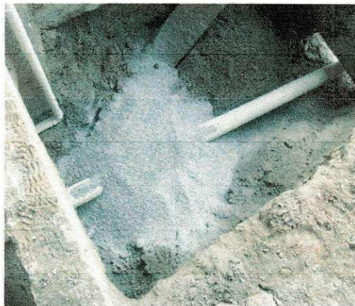
FOTO 104: ATERRO DA REDE DE ESGOTO
