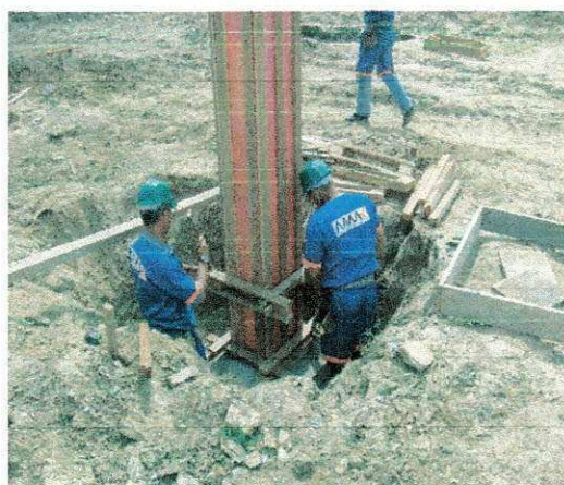
FOTO 30: MONTAGEM DA FORMA
