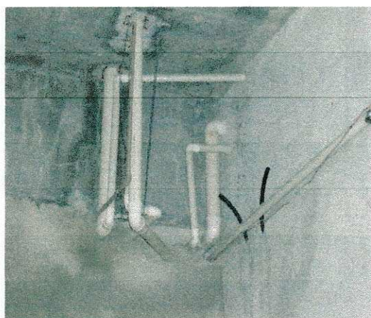
FOTO 102: REDE DE ESGOTO SOB A LAJE
