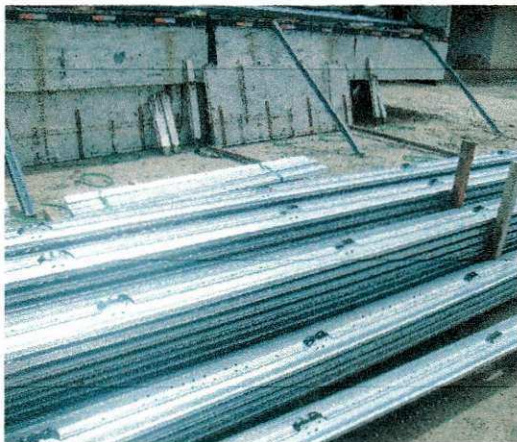
FOTO 92: PERFIS DE AÇO PRÉ-FABRICADAS
