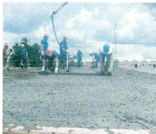
FOTO 67: ACABAMENTO DA LAJE
