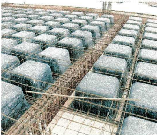
FOTO 64: ARMAÇÃO DA FERRAGEM
