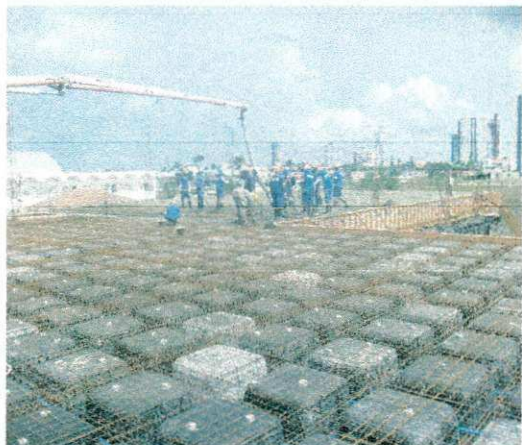
FOTO 66: LANCAMENTO DO CONCRETO
