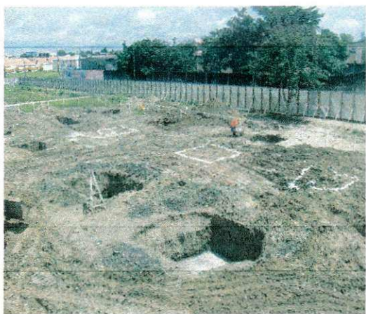
FOTO 7: ESCAVAÇÃO E MARCAÇÃO DAS FUNDAÇÕES
