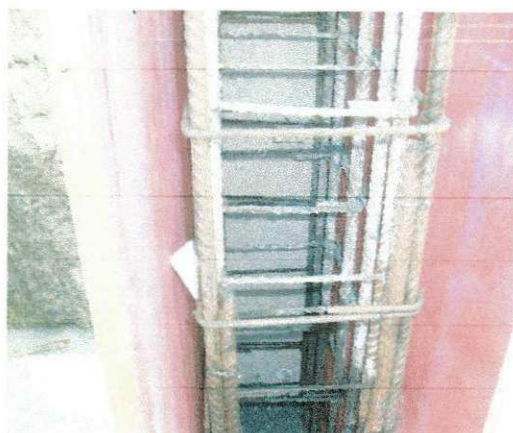
FOTO 33: FORMA PRONTA PARA CONCRETAGEM
