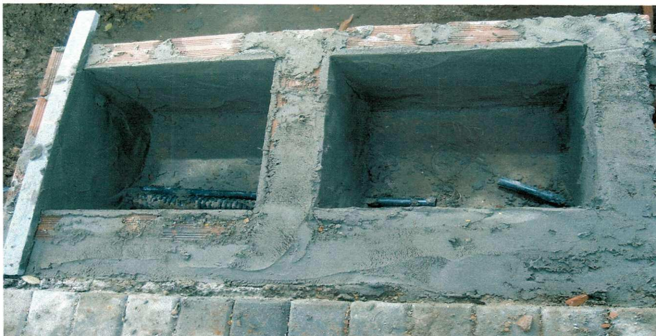
Figura 03: Revestimento de reboco.
