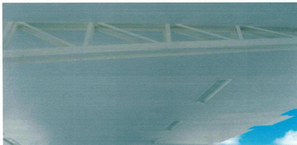
Figura 21: Treliças utilizadas no pavimento de espera.
