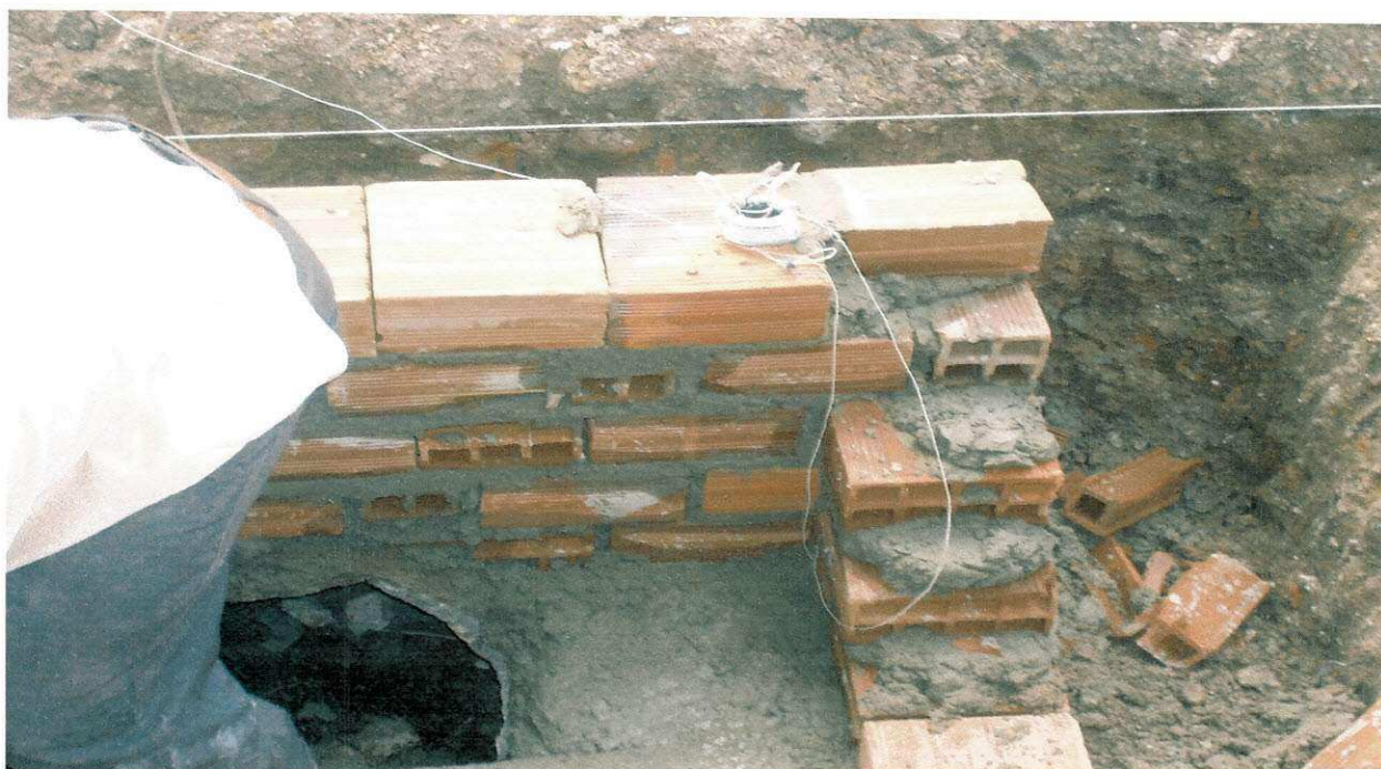
Figura 25: Alvenaria em tijolos cerâmicos, sentados de uma vez, para captação de águas pluviais.
