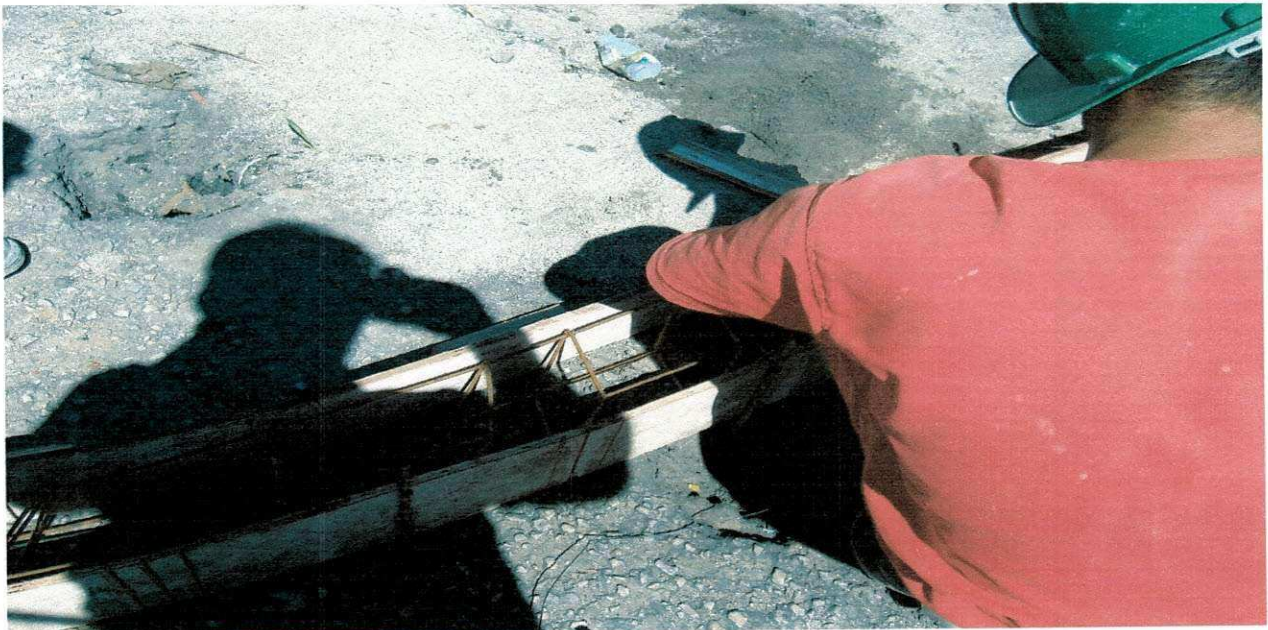
Figura 16: Colocação de formas e armaduras.
