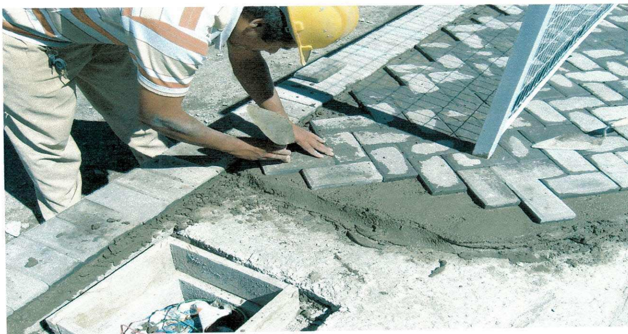
Figura 11: Assentamento do pavê.
