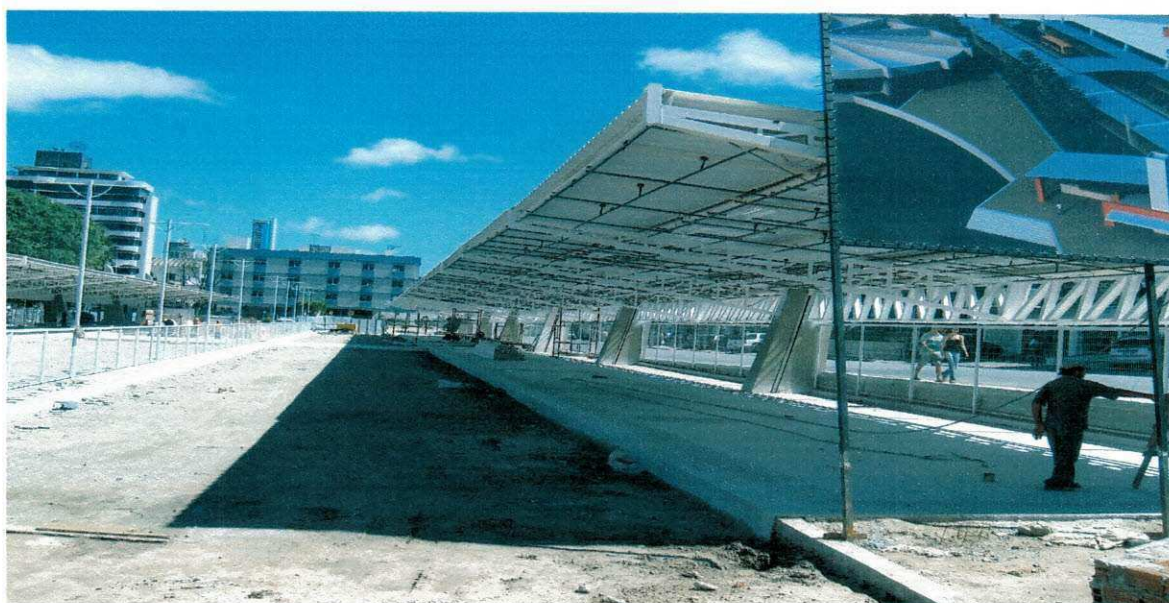
Figura 28 Estruturas em aço, utilizada na cobertura do pavimento de espera.
