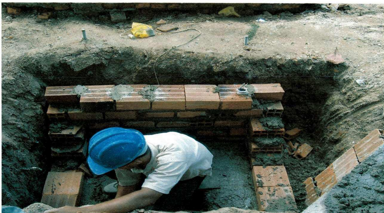
Figura 26: Alvenaria em tijolos cerâmicos, sentados de uma vez, com o auxílio de prumos e linha mestra.
