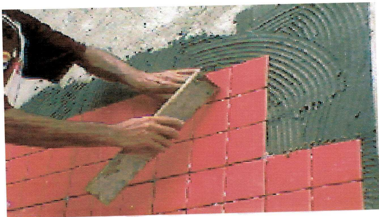
Figura 05: Assentamento das Pastilhas cerâmicas.
