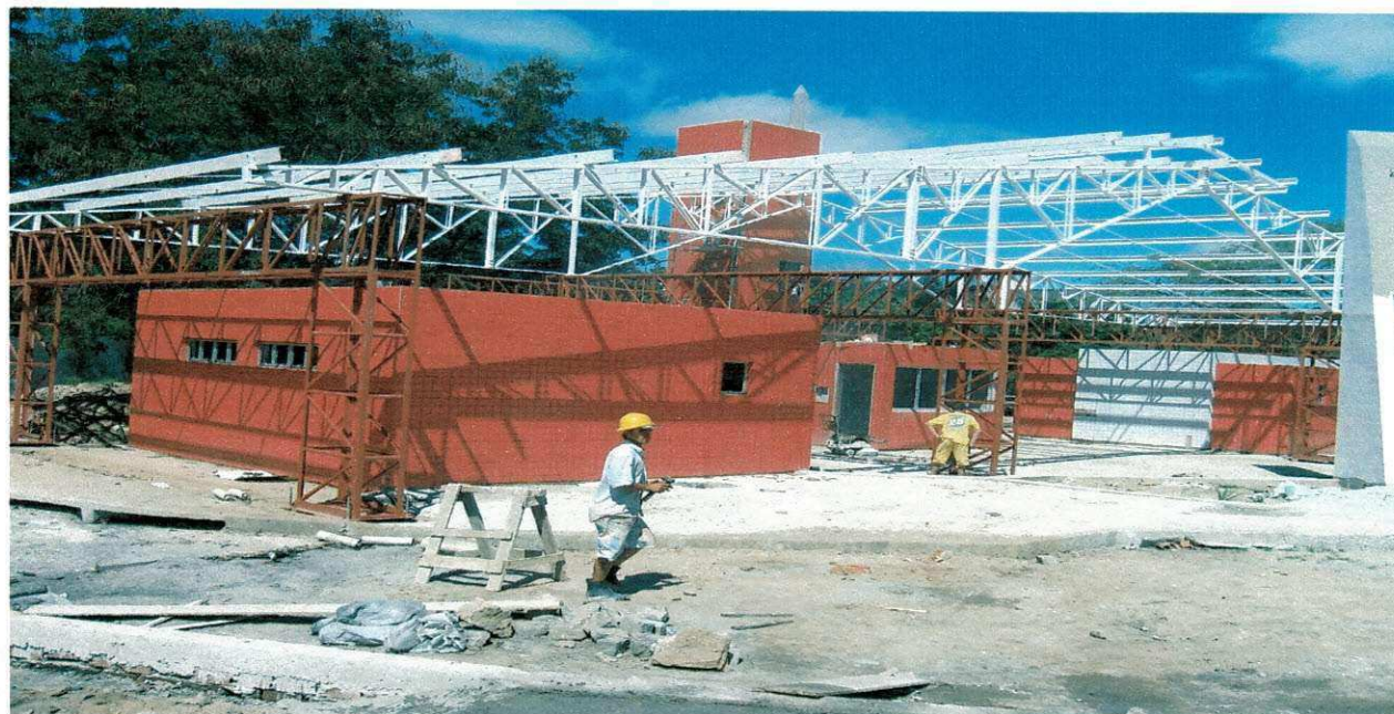
Figura 20: Estruturas em aço, utilizada na cobertura da unidade de apoio.
