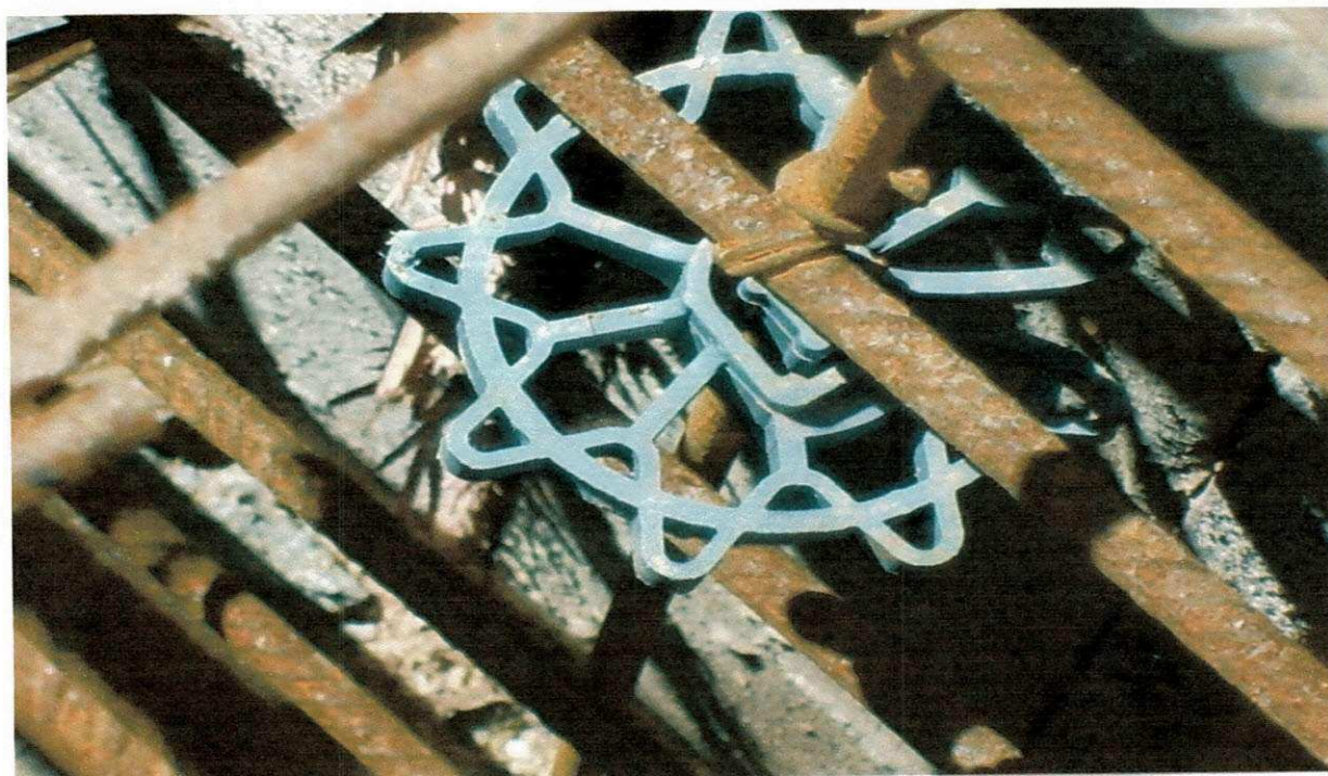
Figura 19: Espaçadores de plásticos, utilizados para dar o recobrimento necessário à armadura.
