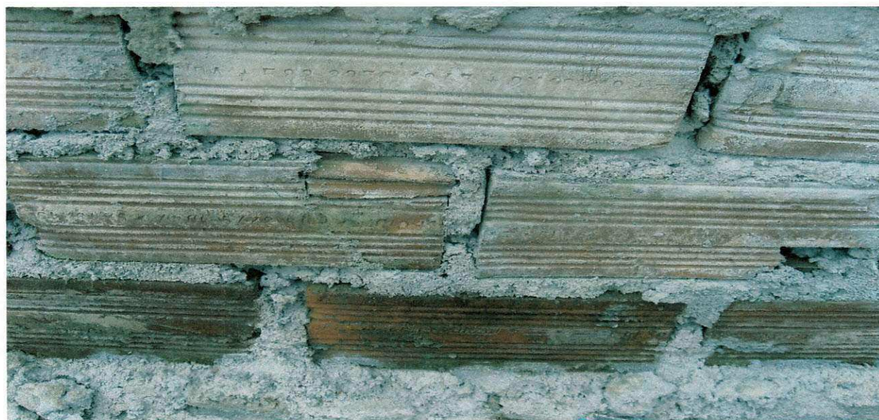
Figura 24: Alvenaria em tijolos cerâmicos, sentados de uma vez.
