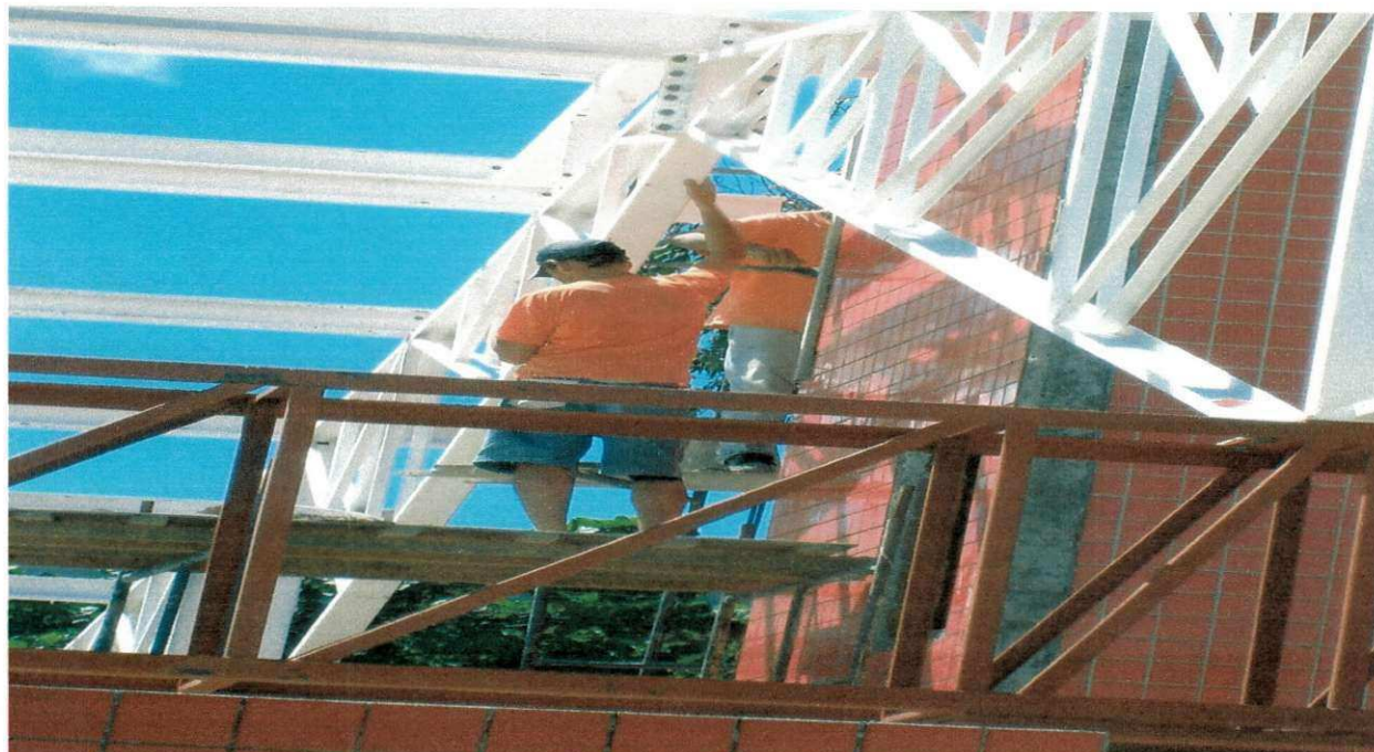
Figura 22: Outra visão da estruturas em aço, utilizada na cobertura da unidade de apoio.
