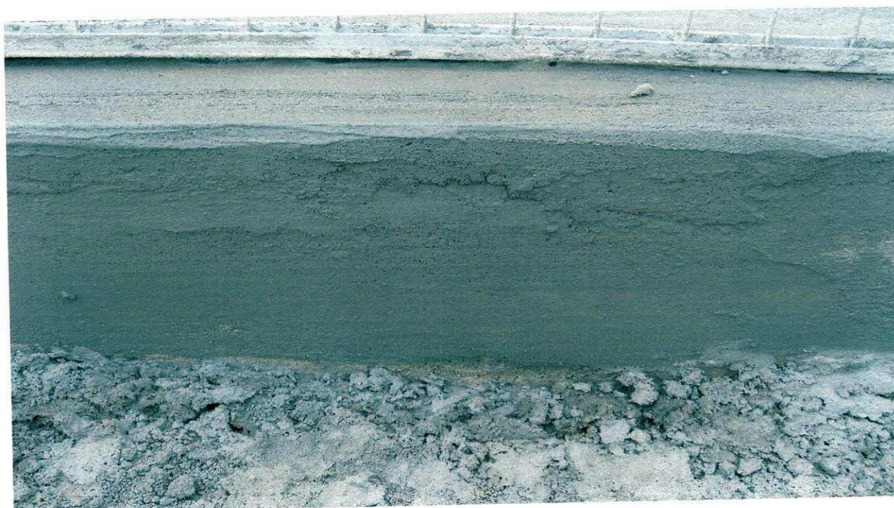
Figura 02: Revestimento de reboco.
