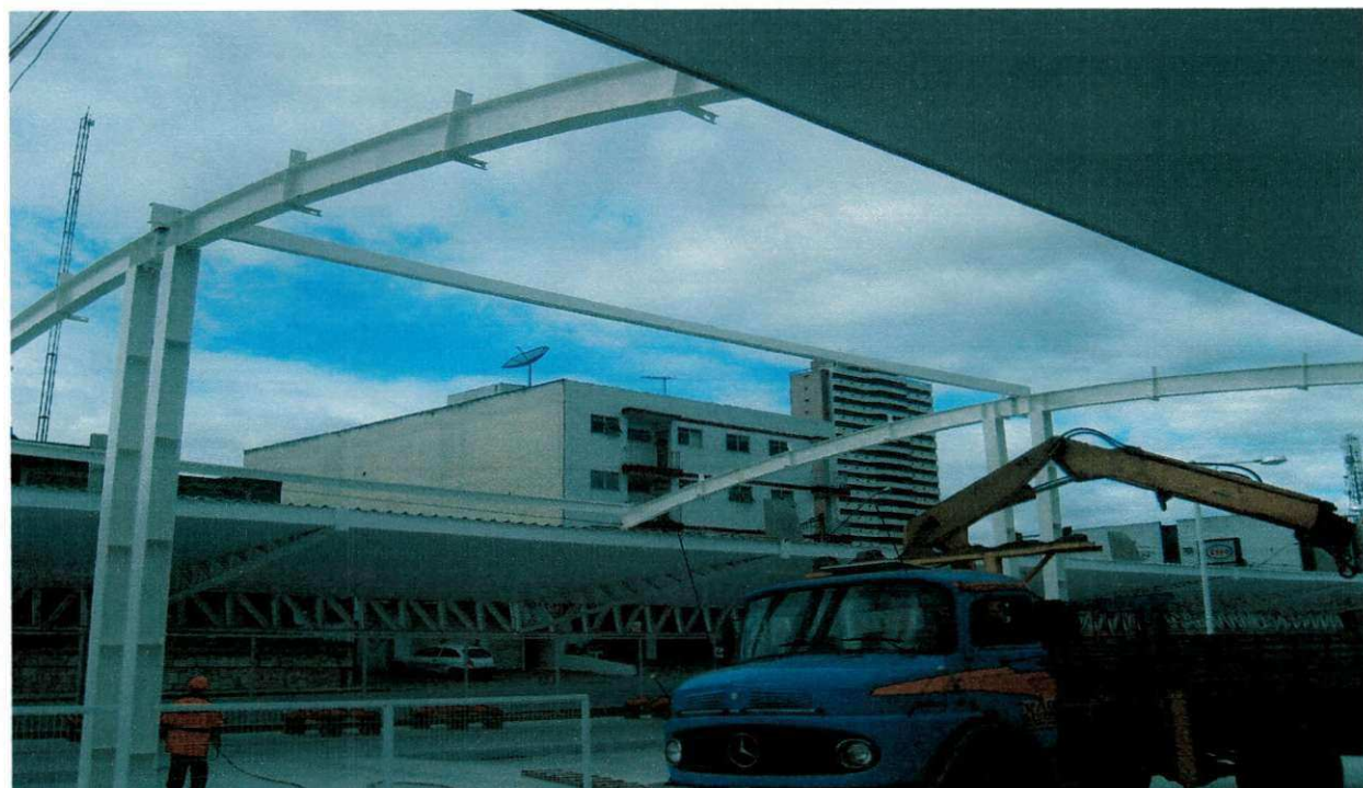
Figura 23: Estruturas em aço, utilizada na cobertura da passarela.
