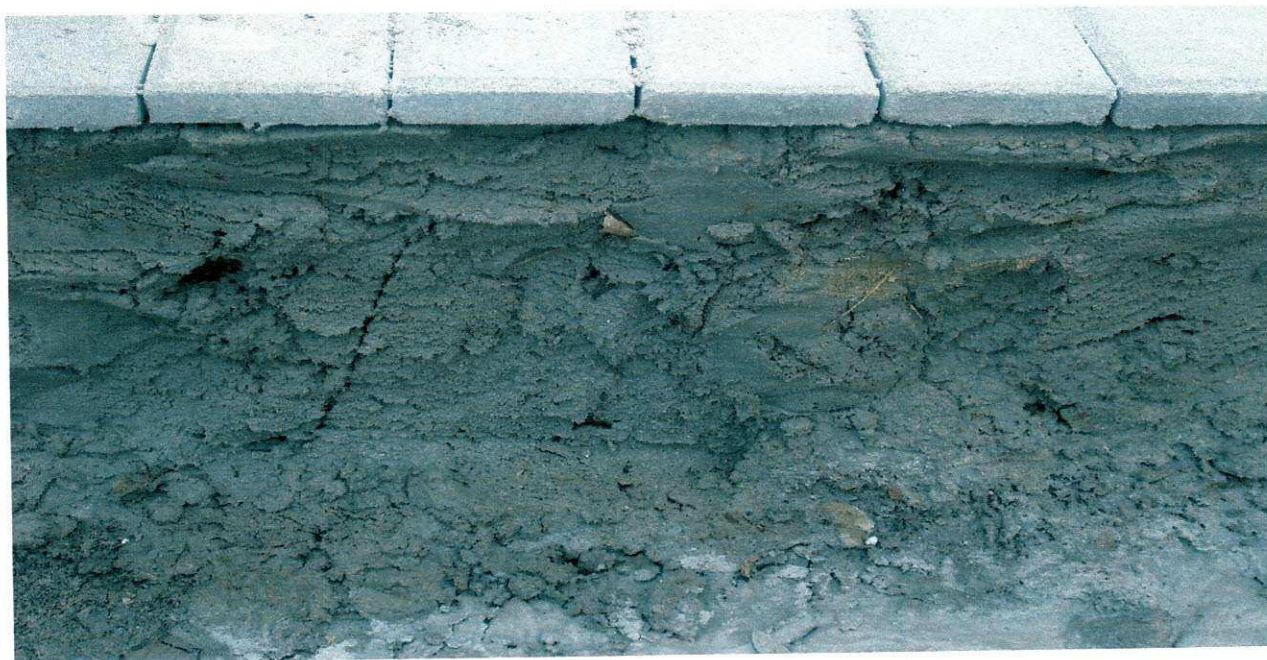
Figura 01: Revestimento de chapisco.
