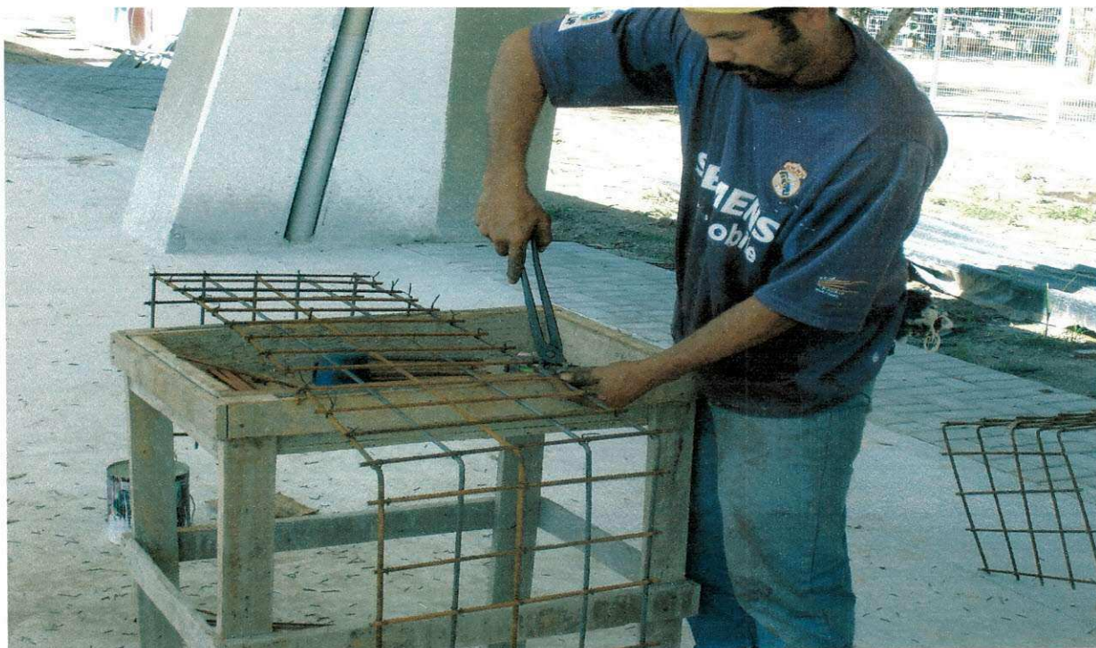
Figura 18: Montagem da armadura, utilizadas nos banquinhos.
