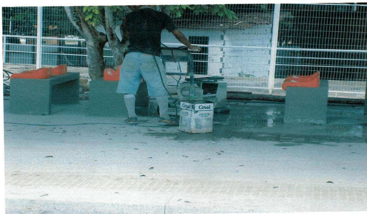
Figura 09: Polimento do granilite, através de discos polidores.
