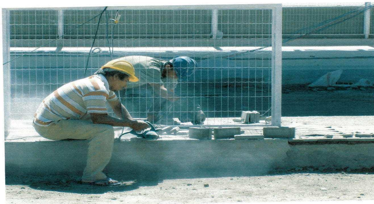
Figura 12: Assentamento do pavê, utilizando máquina.
