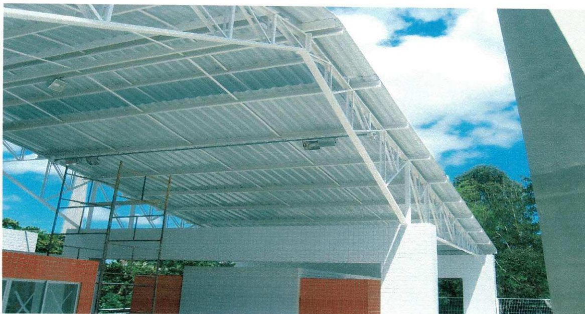
Figura 27: Estruturas em aço, utilizada na cobertura da unidade de apoio.
