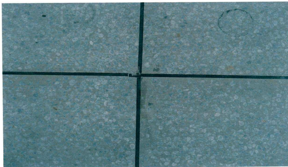
Figura 07: Juntas de dilatação para o piso de granilite.
