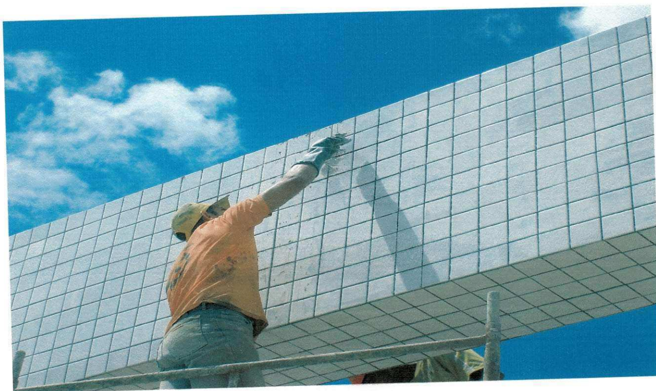
Figura 06: Preenchimento das juntas.
