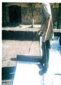
Figura 16: Impermeabilização com alumínio.
