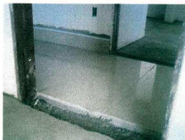
Figura 13: Colocação de soleiras e rodapés.
