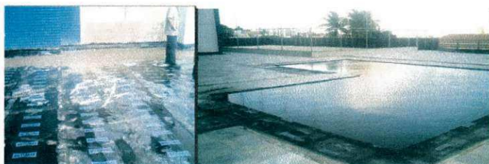
Figura 10: Impermeabilização da piscina.
