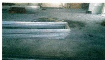
Figura 11: Esquadrias para colocação nas portas.
