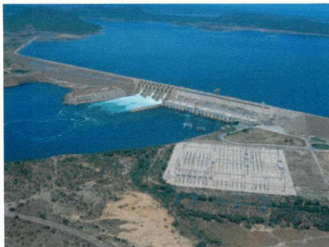
Figura 12 – Vista frontal da barragem de Itaparica
