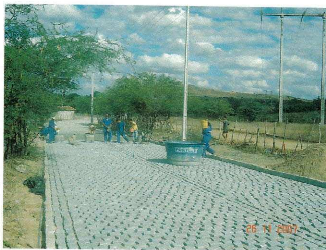
Figura 41 – Trecho do acesso sendo rejuntado com argamassa de cimento e areia
