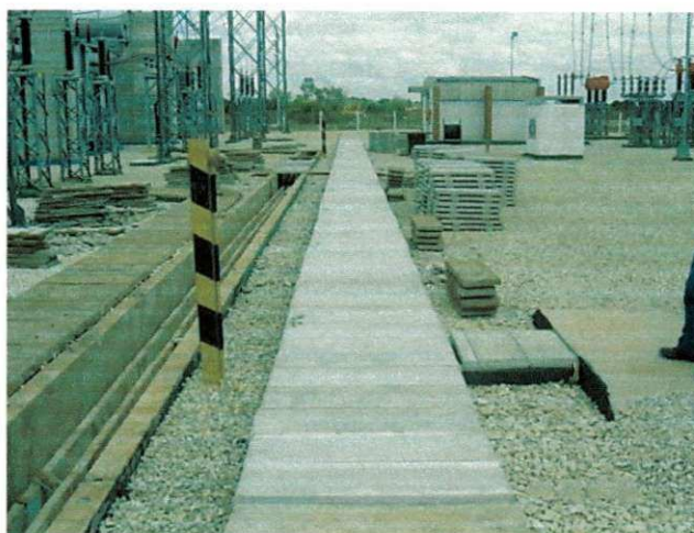
Figura 46 – Instalação de novas tampas de canaletas SE ACD
