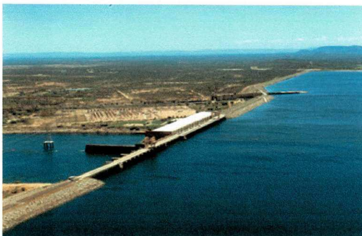
Figura 14 – Vista lateral da barragem de Sobradinho
