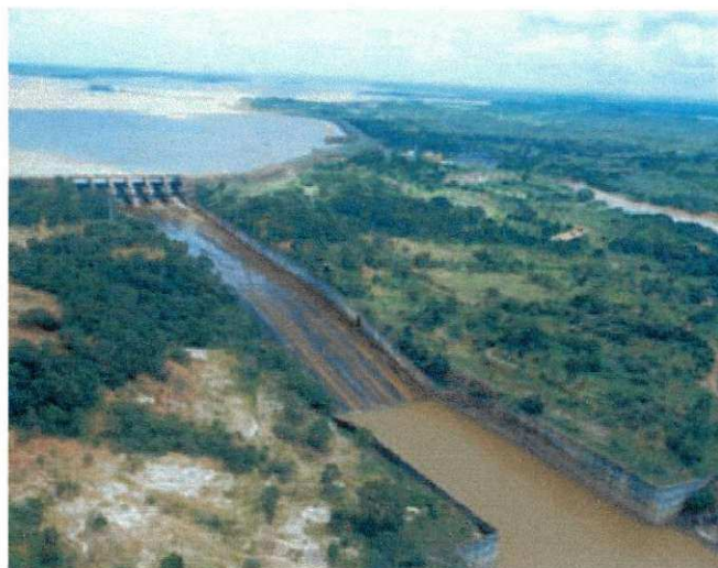
Figura 16 – Sangradouro da barragem de Boa Esperança
