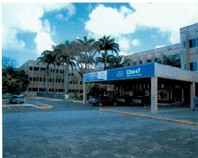
Figura 1 – Edifício André Falcão – Sede da Chesf
