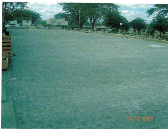
Figura 40 – Pavimentação pronta em frente à casa de comando
