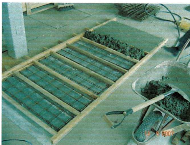
Figura 45 – Confeção de tampas pré-moldadas SE CGD
