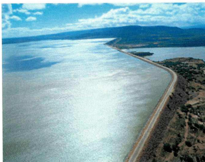
Figura 13 – Vista lateral da barragem de Itaparica
