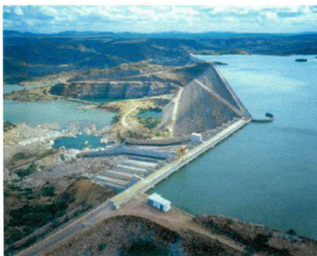
Figura 7 – Vista lateral da barragem de Xingó
