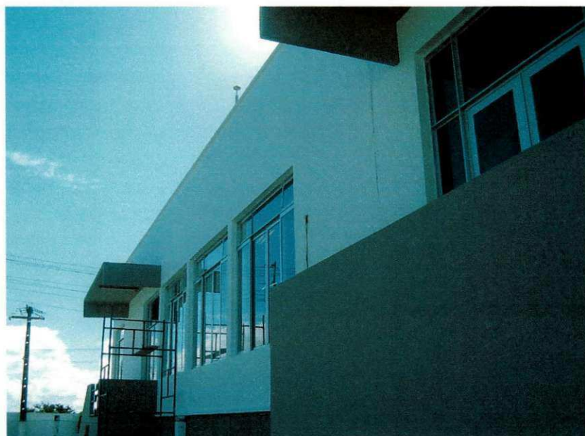
Figura 42 – Prédio de comando SE CGD após os serviços de pintura
