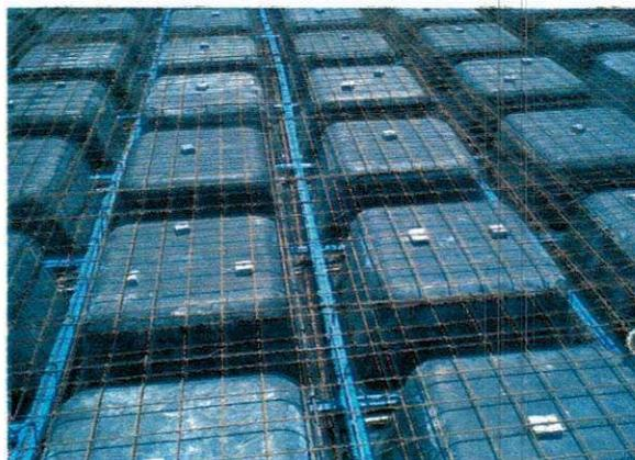
Figura 4.4.5– Laje pronta para a concretagem
