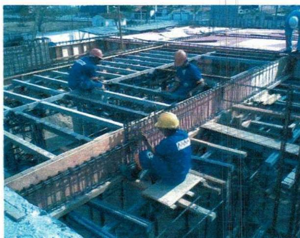
Figura 4.3.1 - Armadura da viga.
