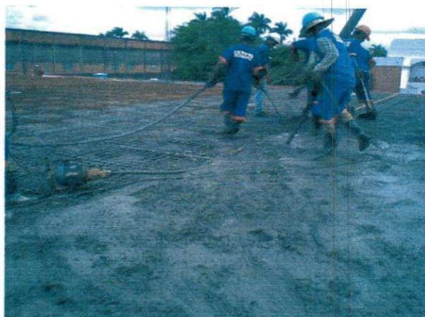
Figura 4.4.5 – Concretagem da laje nervurada
