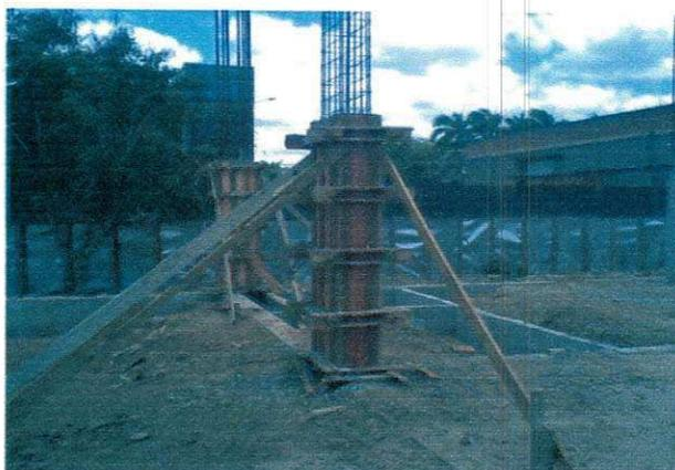
Figura 4.2.2 – Pilar com a fôrma
