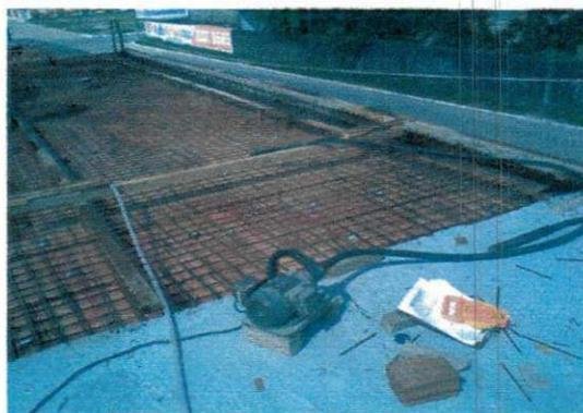
Figura 4.4.3- Laje maciça pronta para a concretagem
