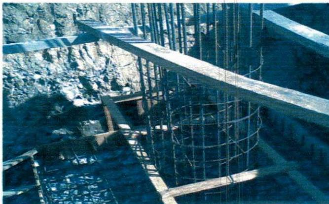
Figura 4.1.1 – Armação da sapata
