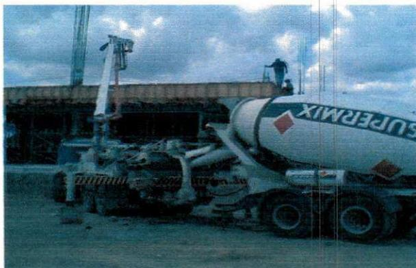
Figura 4.5.1 – Lançamento do concreto
