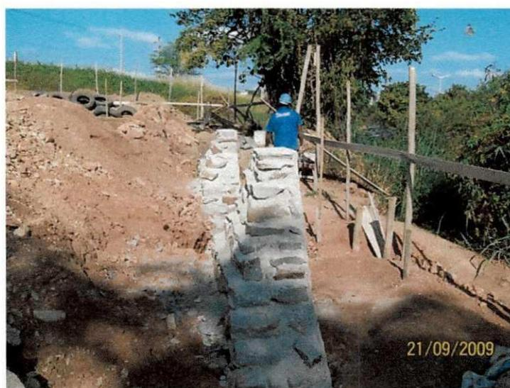
Figura 13 – alvenaria de embasamento
