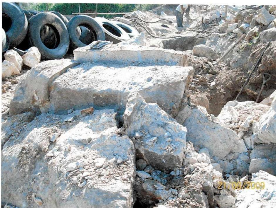
Figura 12 – Solo após a explosão
