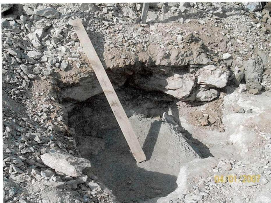
Fig.15 - nivelamento da base do bloco de fundação.
