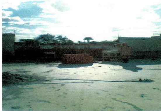
Figura 4 – Empilhamento bloco cerâmico
