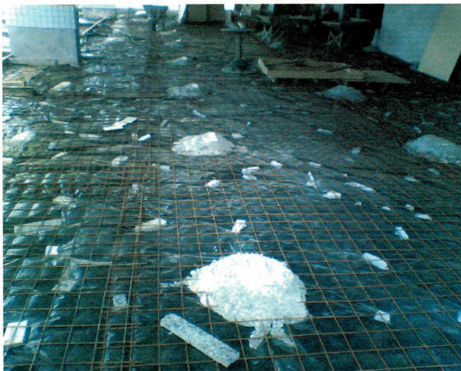
Figura 11 – Concretagem da laje do estacionamento
