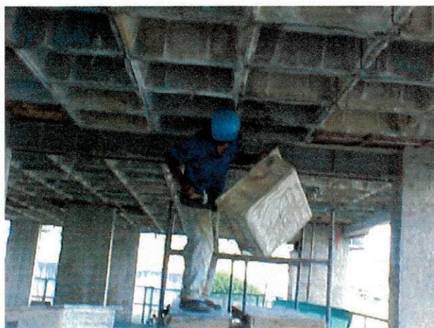
Figura 1 (Fôrma Plástica sendo retirada)
