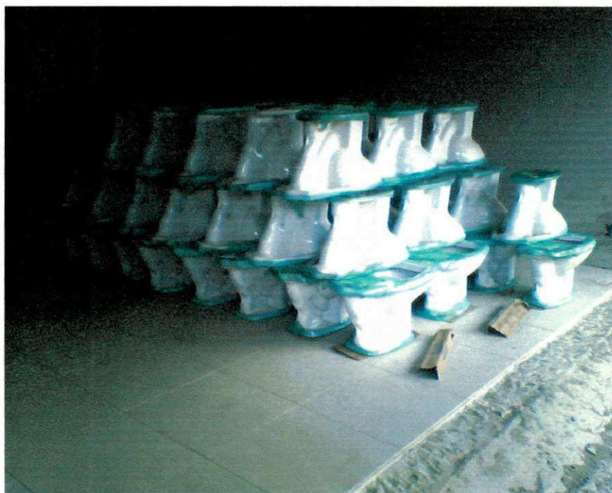
Figura 9 - Empilhamento do vaso sanitário
