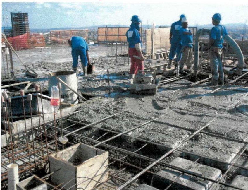
Figura 4.12 – Molhagem e nivelção do concreto
