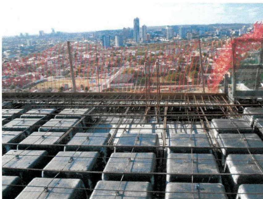
Figura 4.8 – Maciço junto ao pilar
