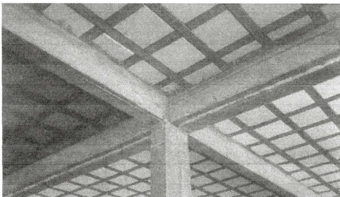
Figura 2.3 – Laje nervurada bidirecional (FRANCA & FUSCO, 1997)
