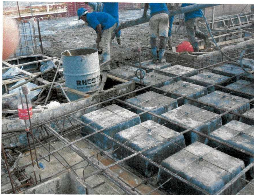
Figura 4.10 – Enchimento da laje
