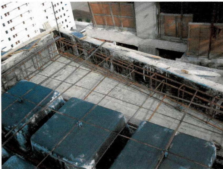
Figura 4.6 – Viga de bordo
