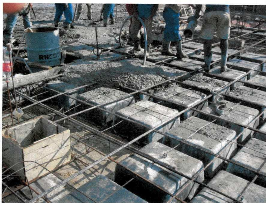
Figura 4.11 – Uso do vibrador
