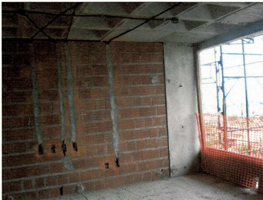
Figura 4.15 – Instalação elétrica 3
