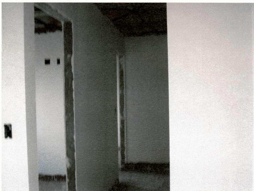
Figura 4.18 – Aplicação do gesso
