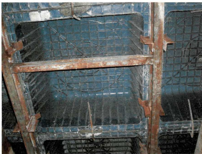
Figura 4.9 – Armação da laje
