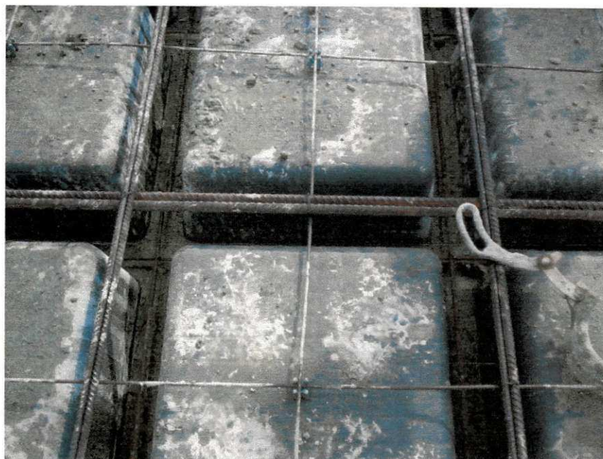
Figura 4.7 – Montagem da laje nervurada
