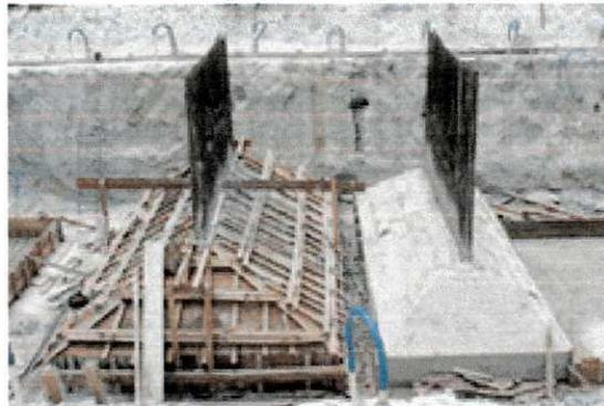
*Figura 4- Fundação em sapata*
