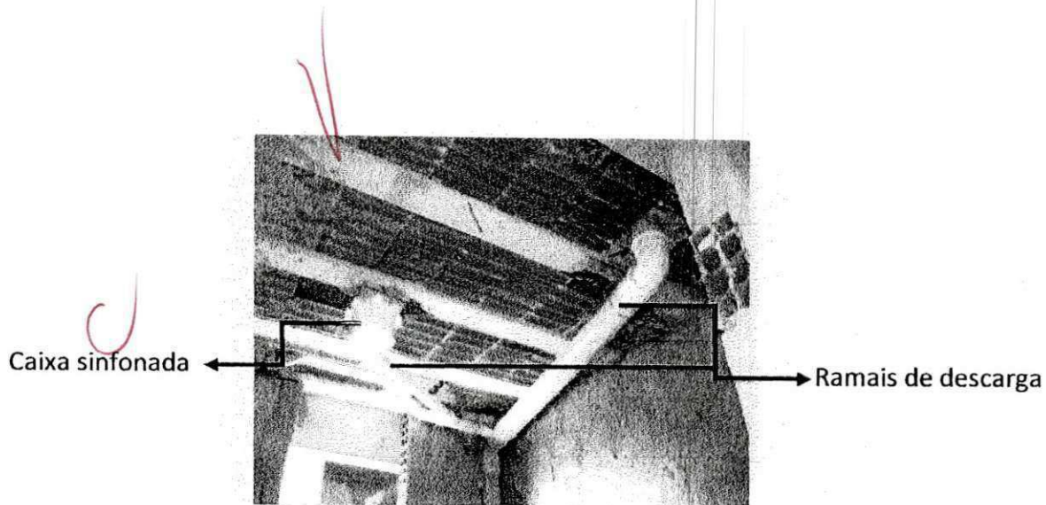
Figura 18 - Instalação de esgoto para o banheiro
