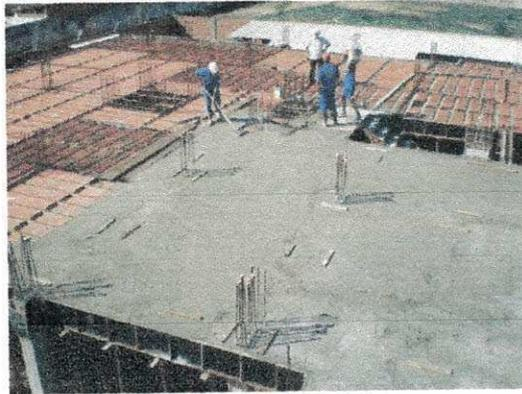
*Figura 15 – Concretagem de laje.*
