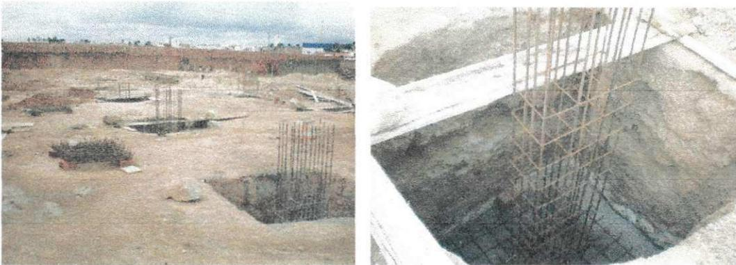
*Figura 7 e Figura 8 – Disposição e detalhamento dos pilares.*
