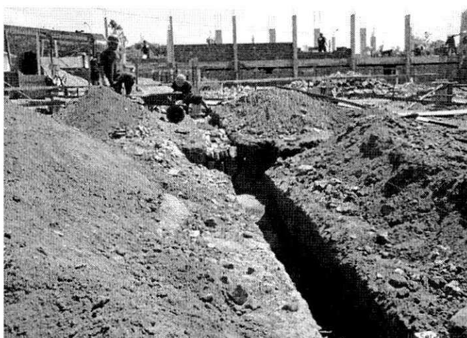
Exemplo de escavação
