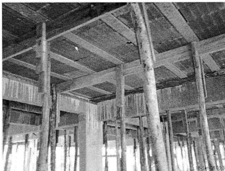
Exemplo de estronca para apoiar lajes pré - moldadas
