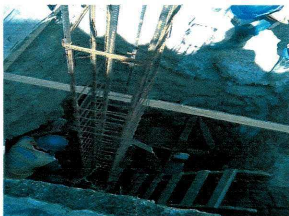
Figura 4.8.1: Cava com lastro de concreto recebendo fôrmas e armação
