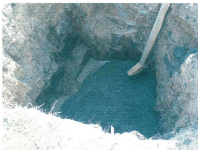
Figura 4.7.1: Colocação de concreto nas escavações para pilares.
