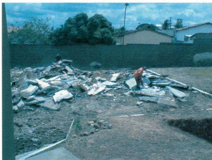
Figura 4.2.2: Retirada de base de concreto ao lado do prédio existente.
