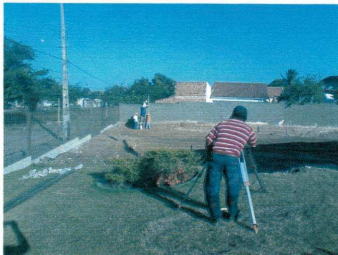
Figura 4.2.1: Marcação do nível antes dos trabalhos de locação.
