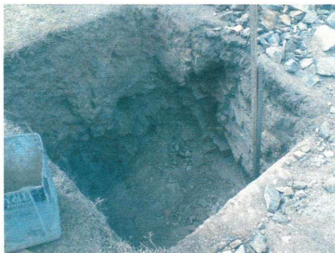
Figura 4.6.1: Escavação para pilar.
