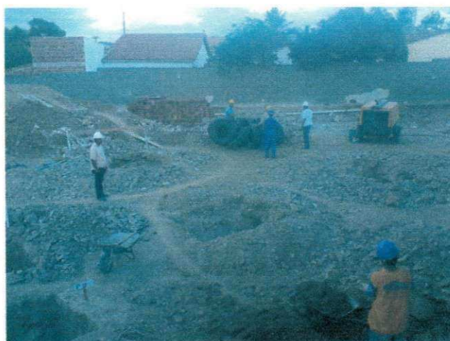
Figura 4.6.2: Colocação de pneus para abafamento nas detonações
