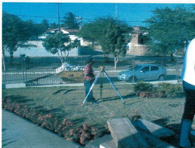
Figura 4.5.1: Locação da obra com o auxílio de aparelhos topográficos (estação total).
