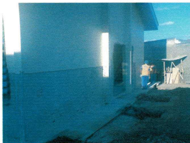
Figura 4.11.3: Fachada pronta para receber revestimento cerâmico
