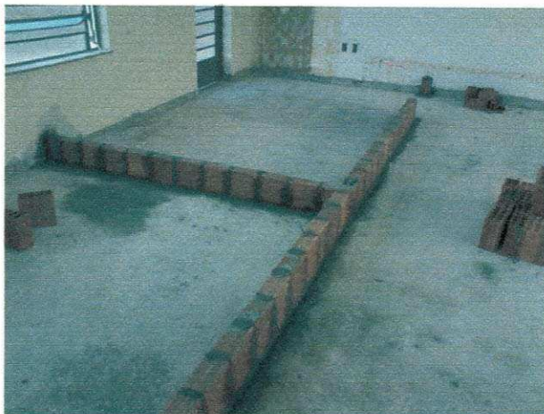
Figura 4.10.2: Alvenaria de marcação
