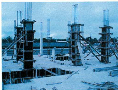
Figura 9 - Fôrmas e escoramentos para pilares
