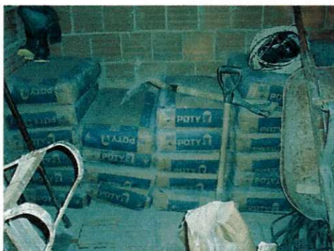
Figura 14 – Armazenamento do cimento
