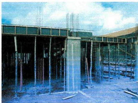
Figura 3 – Estruturas escoradas prontas para o desenfôrme;
