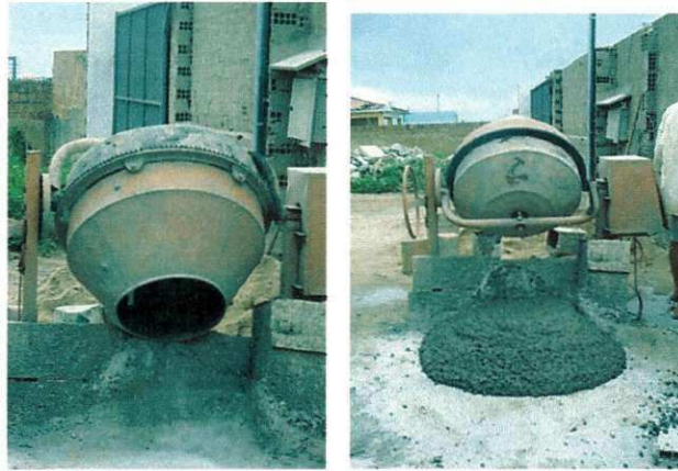
Figura 7 - Processo de fabricação do concreto in loco
