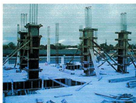
Figura 3 – Estruturas escoradas prontas para o desenfôrme;
