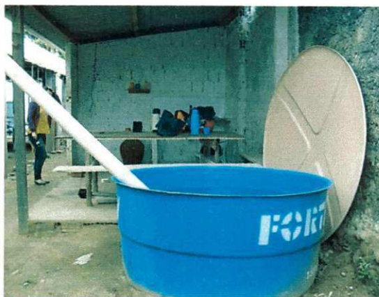
Figura 13 – Aproveitamento das águas pluviais
