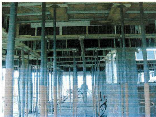
Figura 2- escoramento da laje pré-fabricada do pilotis
