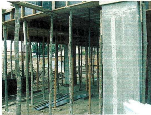
Figura 10 - Pilar depois de retirada a fôrma
