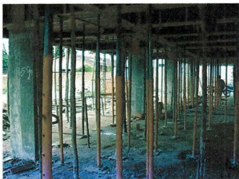
Figura 8 - Fôrmas e escoramentos para lajes e vigas
