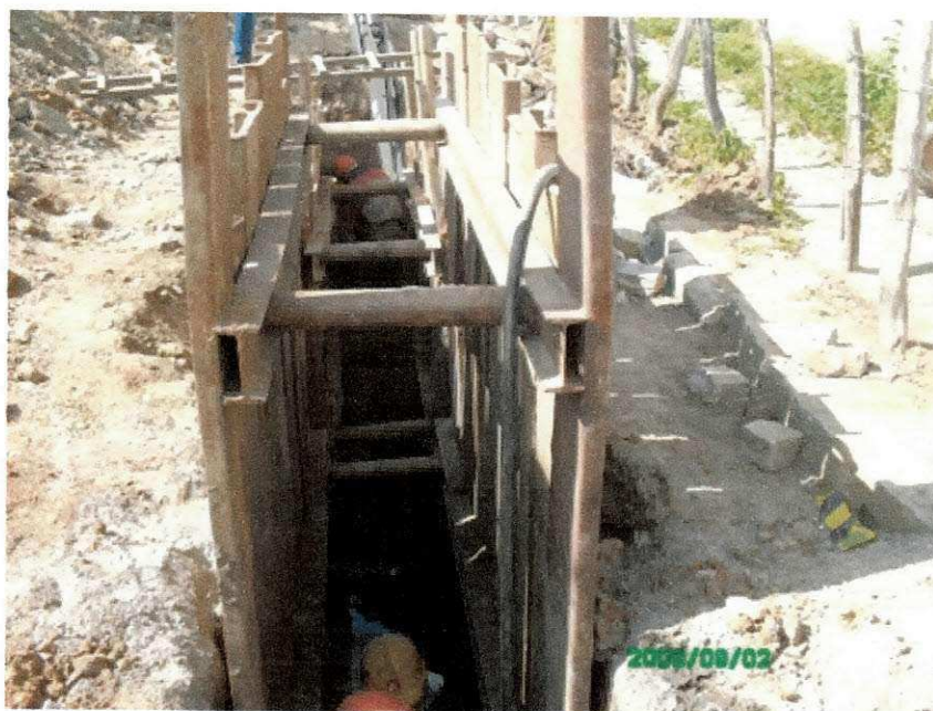
Figura 7- Escoramento de vala
