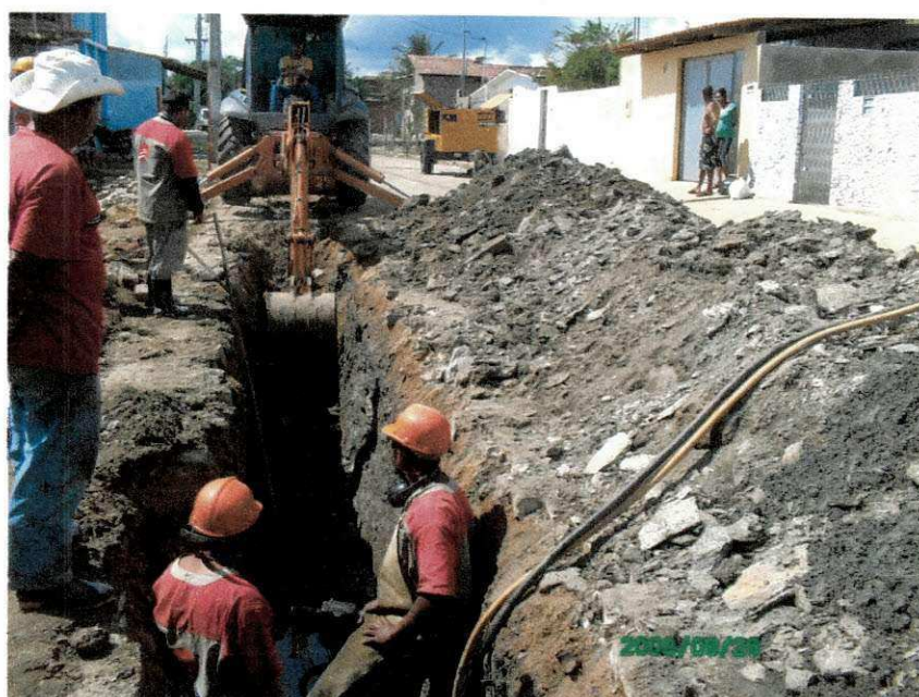
Figura 8 - Escavação em rocha branca
