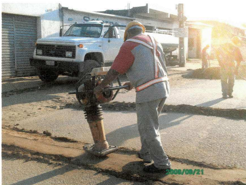
Figura 10 - Apiloamento do material de aterro da vala
