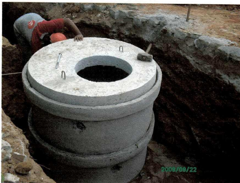
Figura 11 - Execução do poço de visita
