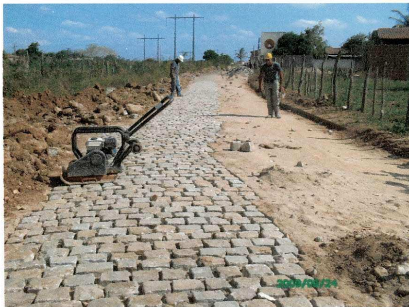
Figura 14 - Recomposição de pavimento em paralelepípedo
