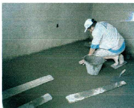
Figura 12 – Marcação e Conclusão do Piso e Contra-Piso
