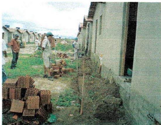
Figura 3 – Canteiro de Obras
