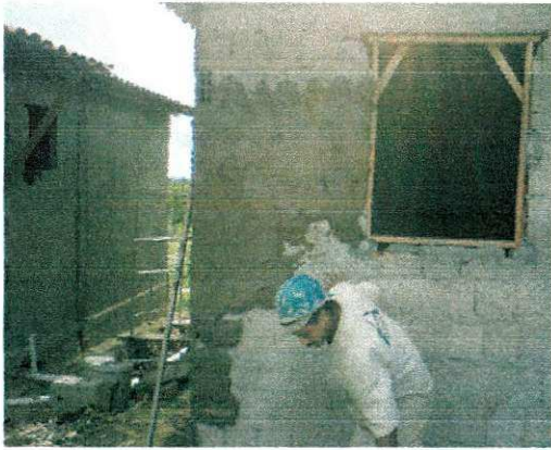
Figura 9 – Argamassa de reboco (I)
