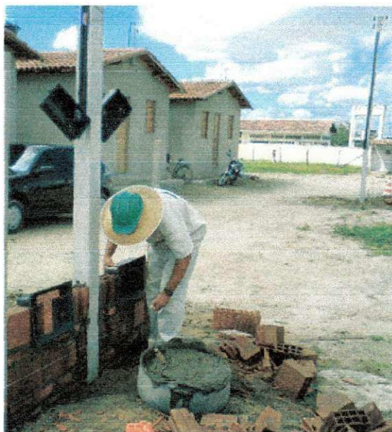
Figura 6 – Marcação e Assentamento
