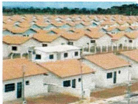
Figura 2 – Conjunto Habitacional (II)
