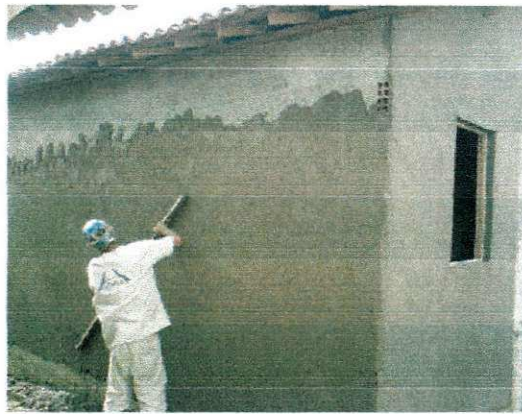
Figura 10 – Argamassa de reboco (II)
