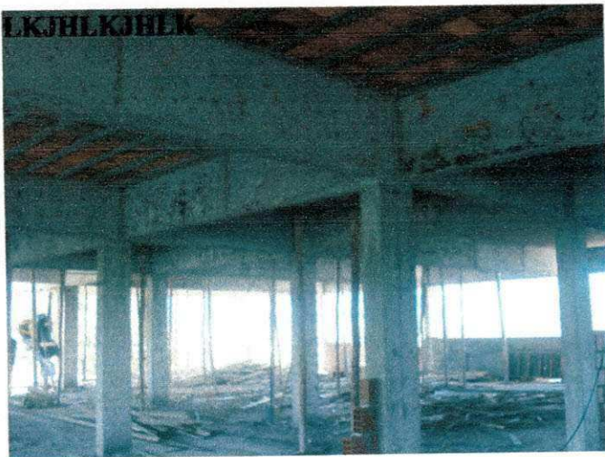
Fig. 11 – Pilares e Vigas
