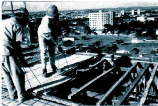
Fig 7.2.1.c Colocação dos elementos pré-moldados
