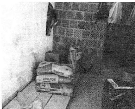
Fig. 6 – Armazenamento do cimento
