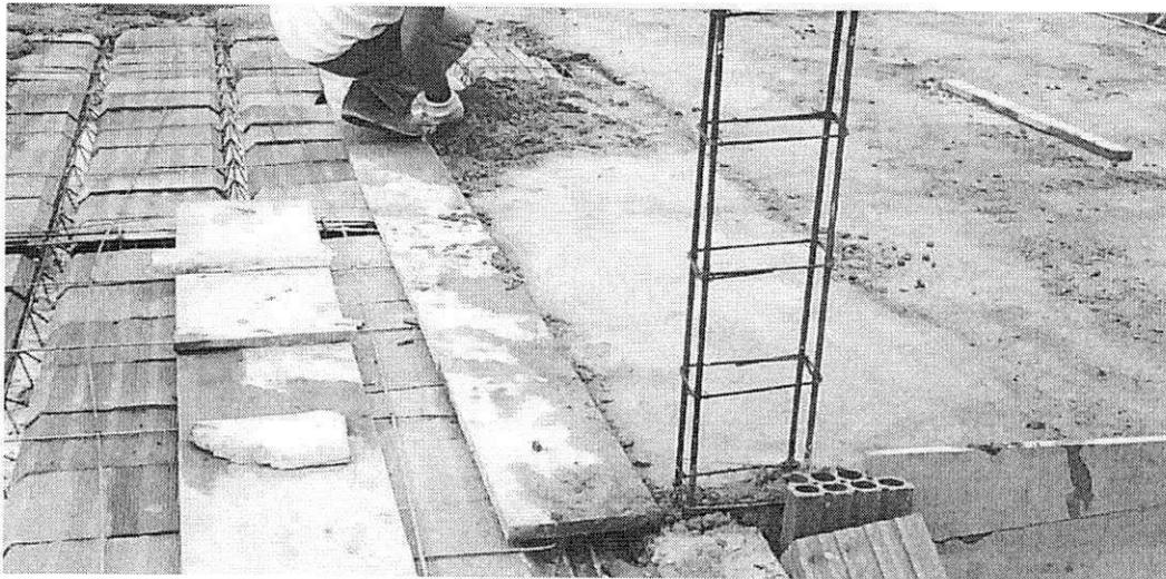
Fig. 33 – Concretagem da Laje
