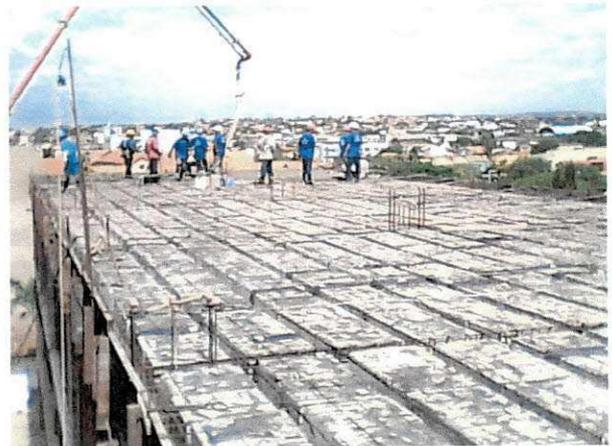
Foto 12 – Laje sendo concretada
