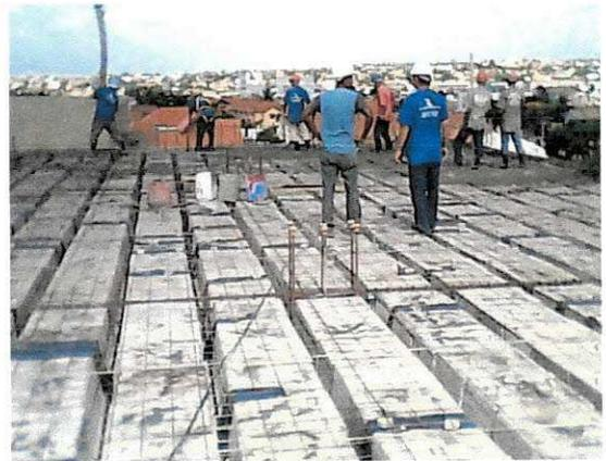
Foto 10 – Laje sendo concretada
