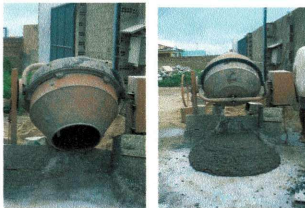
Figura 3 - Processo de fabricação do concreto in locu
