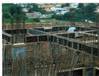
Figura 2 - Operação de montagem de painéis pré-fabricados
