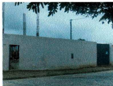
Figura 11 – Portões de acesso à obra
