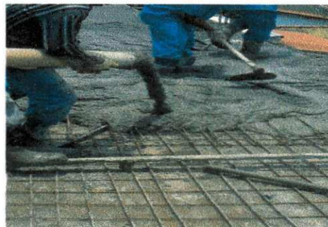
Figura 5 – Concretagem da laje usando O concreto usinado
