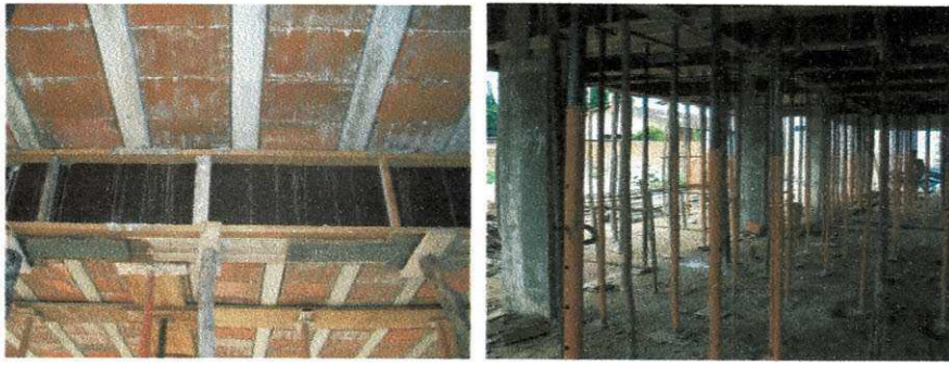
Figura 15 - Fôrmas e escoramentos para lajes e vigas
