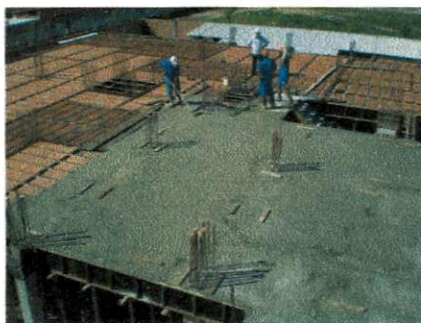
Figura 21 – Operários concretando laje
