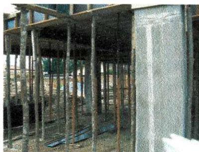
Figura 17 - Pilar depois de retirada a fôrma
