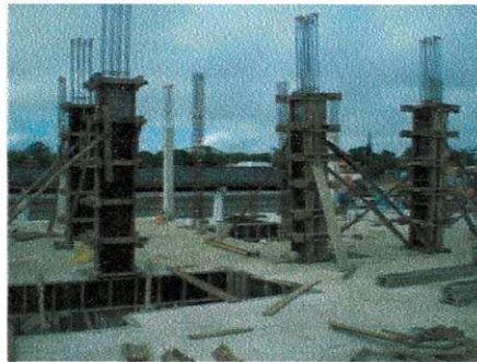
Figura 16 - Fôrmas e escoramentos para pilares
