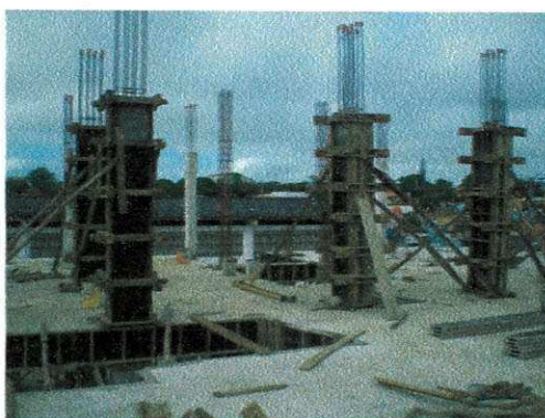
Figura 9 - Armadura à espera do concreto
