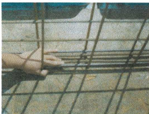
Figura 8 - Verificação dos espaçamentos das ferragens
