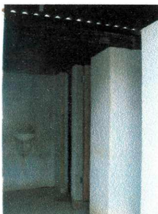
Figura 13 – Vestiários e sanitários
