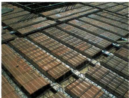
Figura 6 - Laje pré-fabricada antes da concretagem
