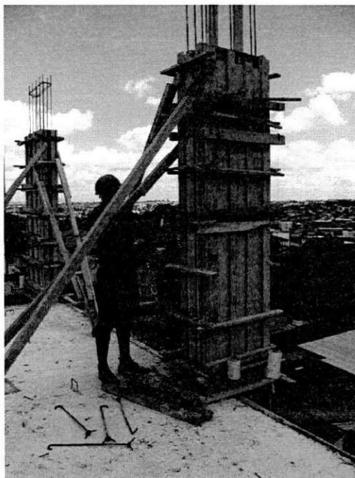
Figura 1. Fôrma de madeira para pilar
