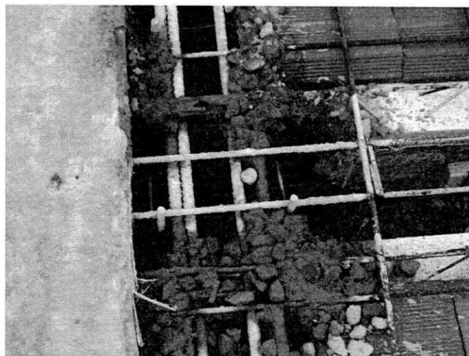
Figura 7. Concretagem de lajes e vigas
