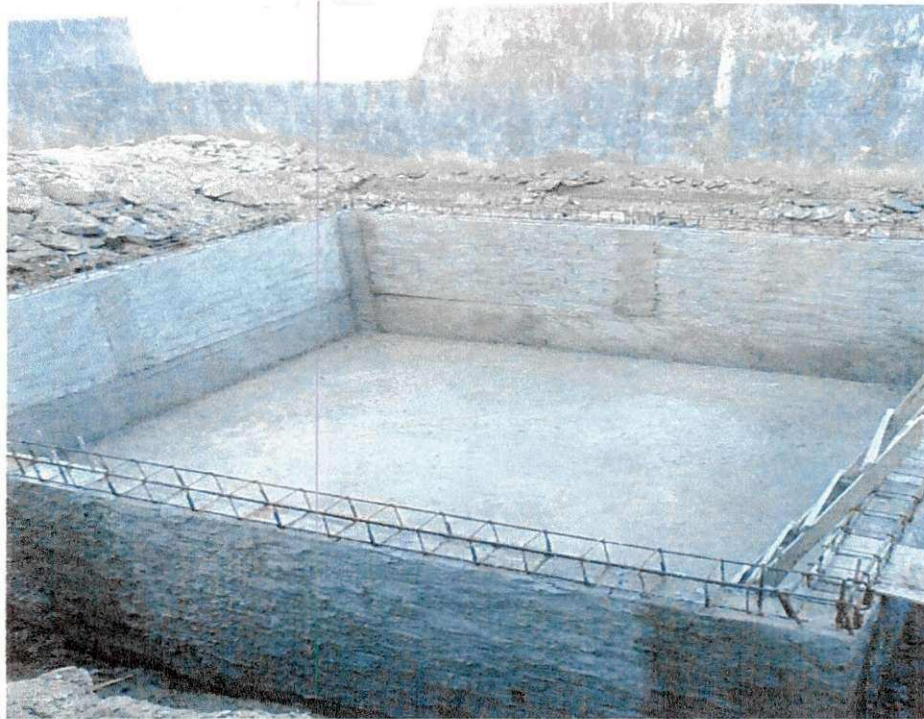
Figura 28. Concretagem do reservatório inferior
