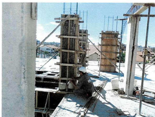
Figura 26. Verificação do prumo do pilar
