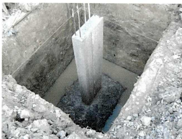
Figura 22. Sapata concretada
