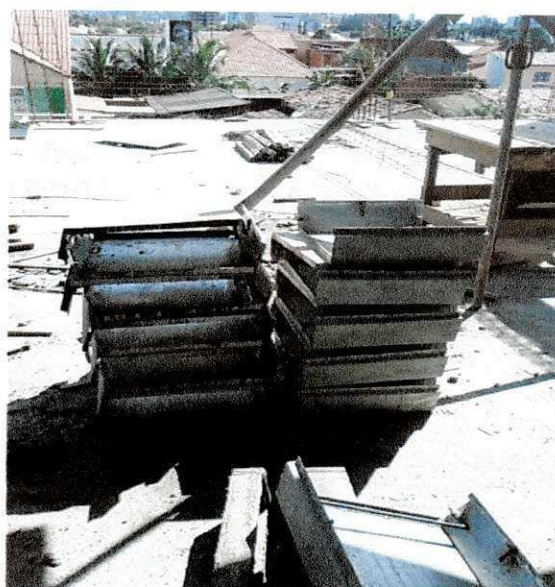
Figura 25. Empilhamento das formas metálicas da laje
