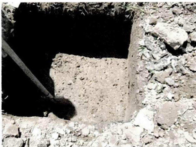
Figura 21. Escavação manual de valas
