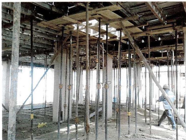
Figura 23. Escoramento metálico
