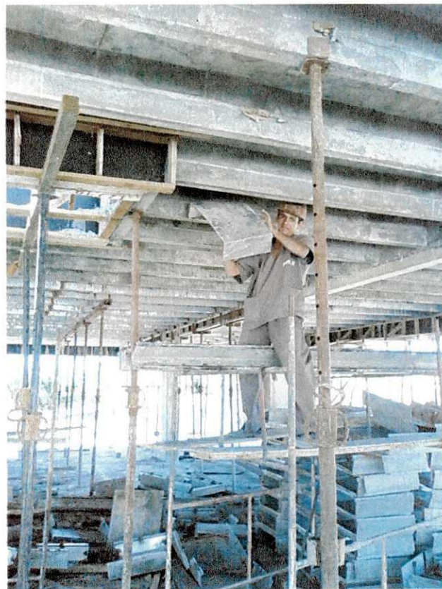
Figura 24. Retiragem das formas da laje
