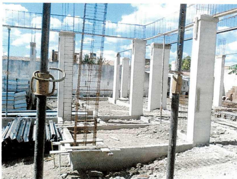
Figura 27. Armaduras pilares e vigas
