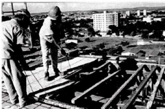
**Fig 7.2.1.c** Colocação dos elementos pré-moldados
