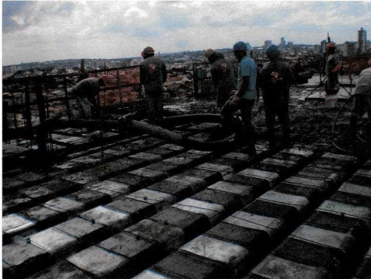
Figura 7.2.5: Concretagem
