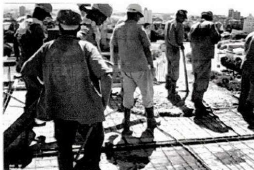
**Fig. 7.2.1.d** Lançamento do concreto
