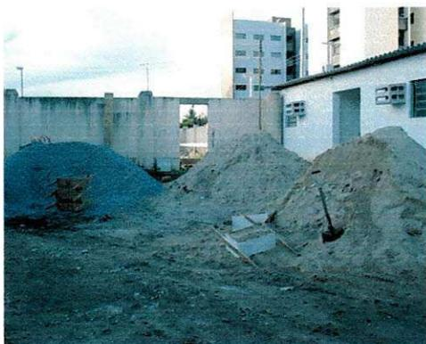
Figura 14 – Estocagem de agregados
