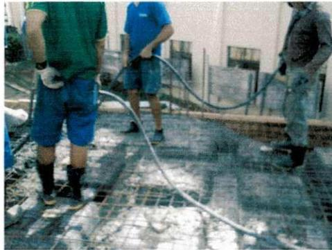
Figura 30 – Operários concretando laje
