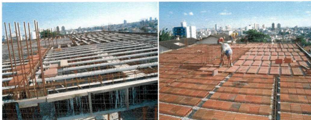
Figuras 29 e 30- Armação da laje.
