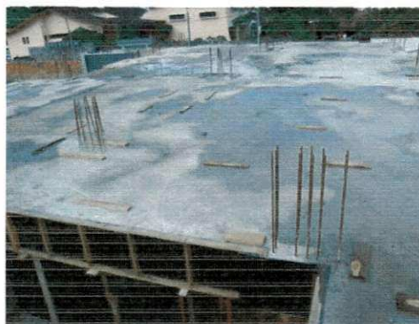
Figuras 31 – Concretagem da laje.
