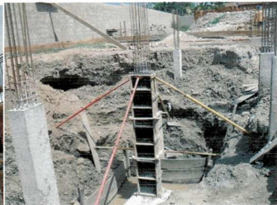
Figura 37 – Fôrma dos pilares.
