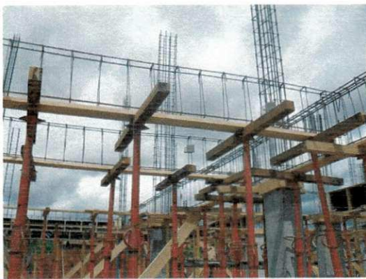
Figura 36 – Escoras das Vigas.
