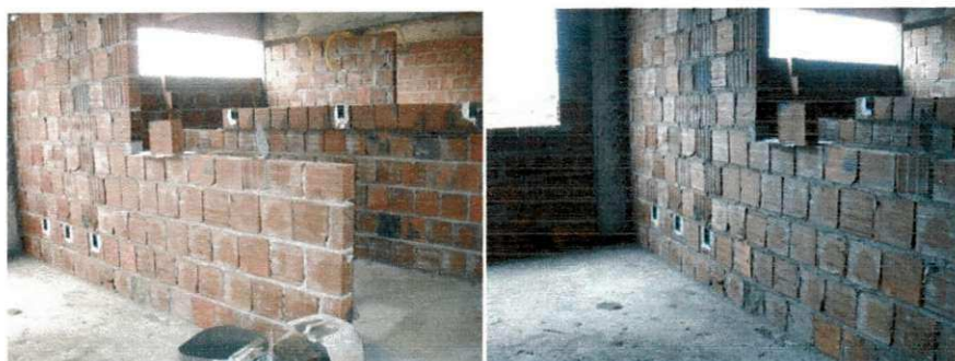
Figura 20 e 21 – Alvenarias de vedação.
