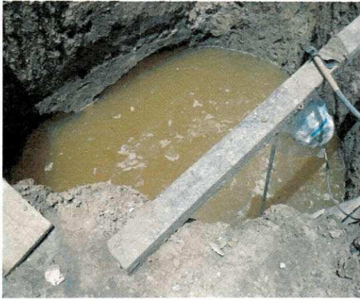
Figura 39 – Drenagem de vala.
