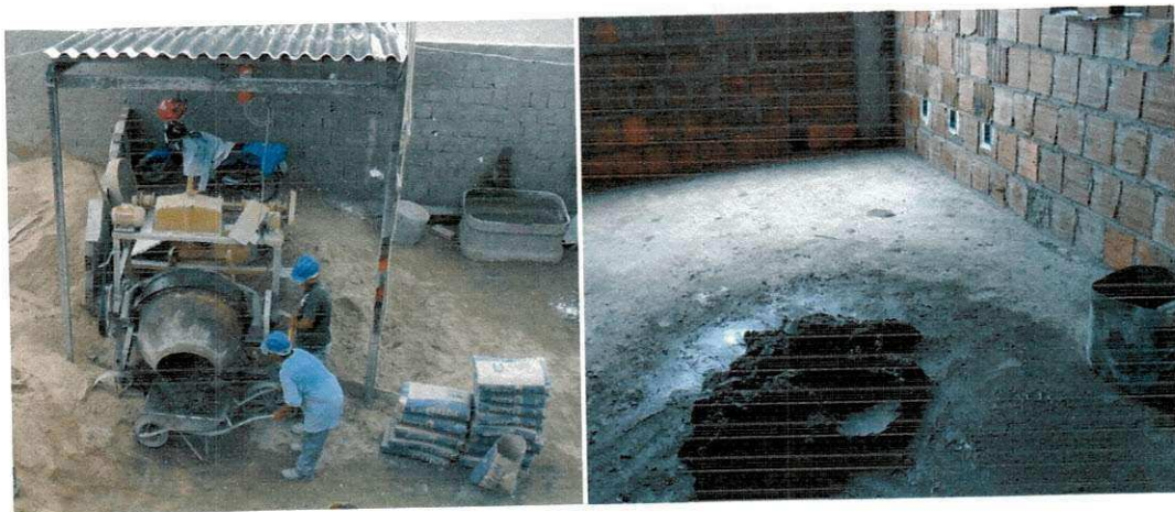
Figura 25 – Argamassa de assentamento.
