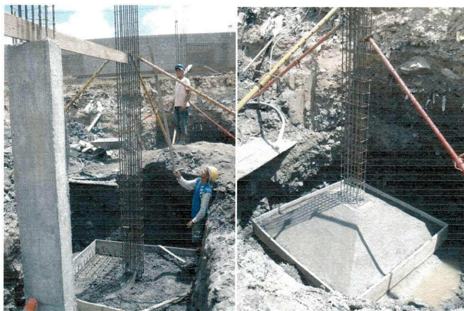
Figura 9 e 10 - Fundação em sapata
