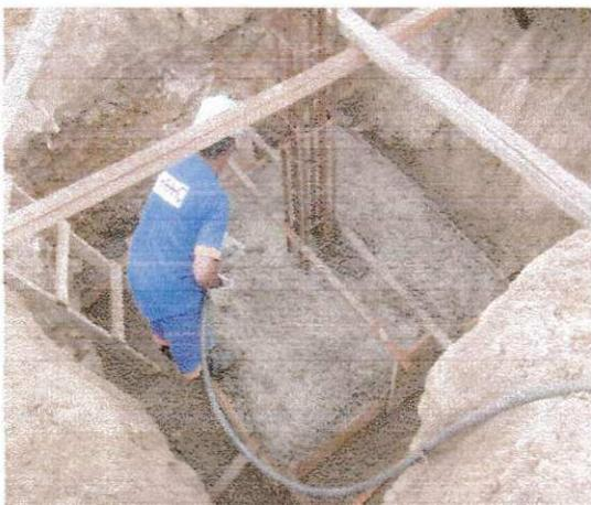
FOTO 22: VIBRAÇÃO DO CONCRETO
