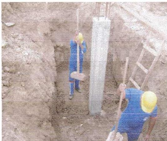
FOTO 25: ATERRAMENTO DA SAPATA
