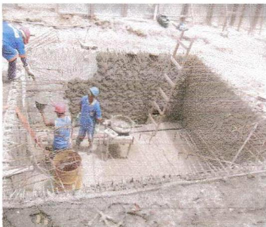
**FOTO 74:** REVESTIMENTO DO RESERVATÓRIO
