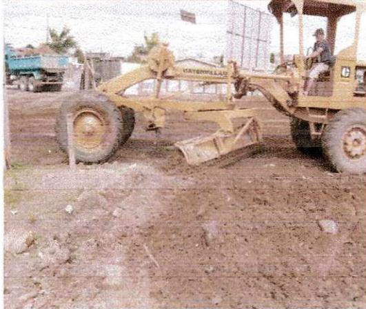
FOTO 12: NIVELAMENTO DO MATERIAL
