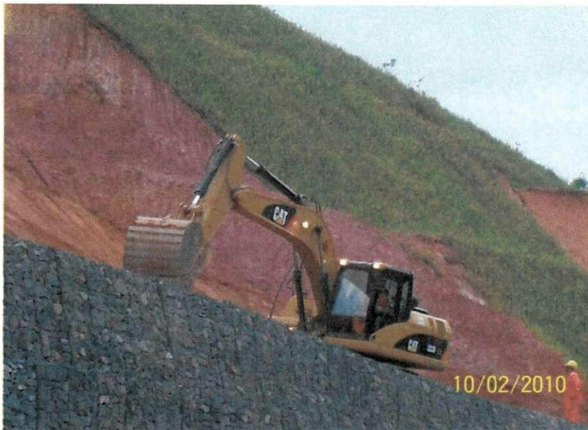
Figura 09: Retaludamento de corte devido a erosão de material.
