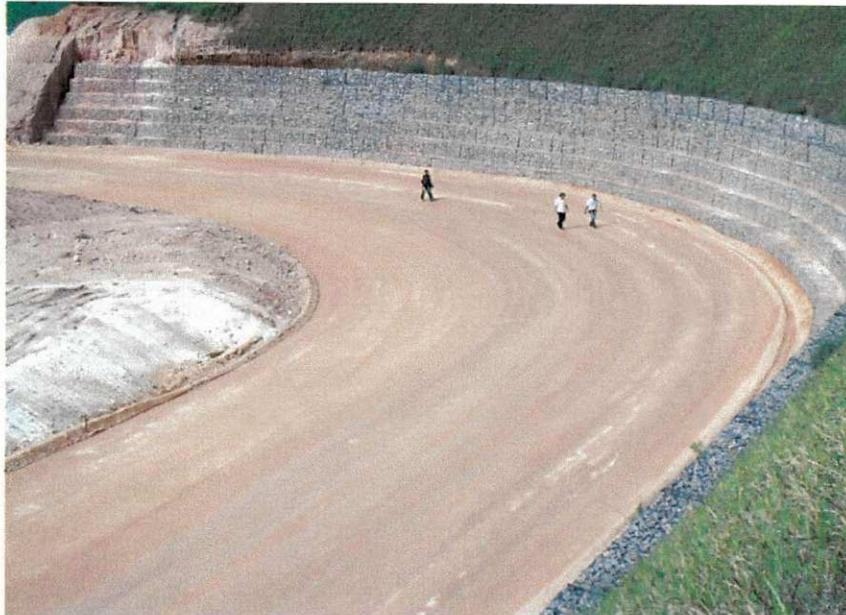
Figura 10: Material de 2ª categoria com necessidade de proteção tipo gabião.
