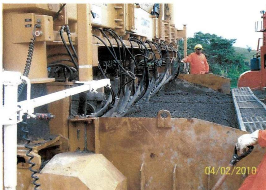
Figura 19: Detalhe da vibro acabadora de concreto.
