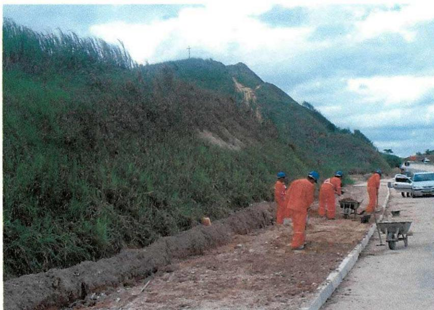
Figura 16: execução do dreno tipo DPS 04 semi-concluído.
