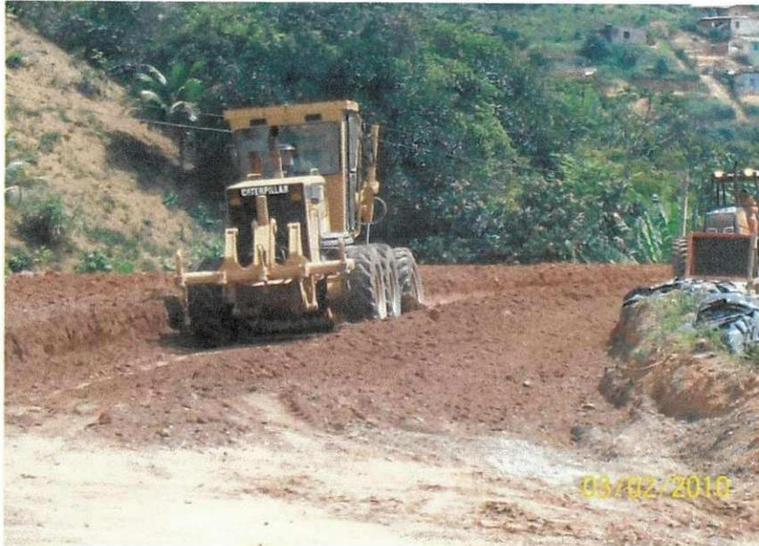
Figura 11: Material selecionado para regularização do aterro.
