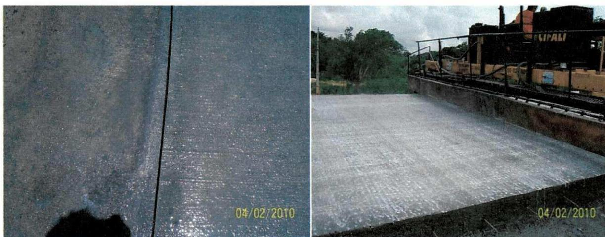
Figura 20: Detalhe de junta mal acabada e colocação da cura no pavimento.
