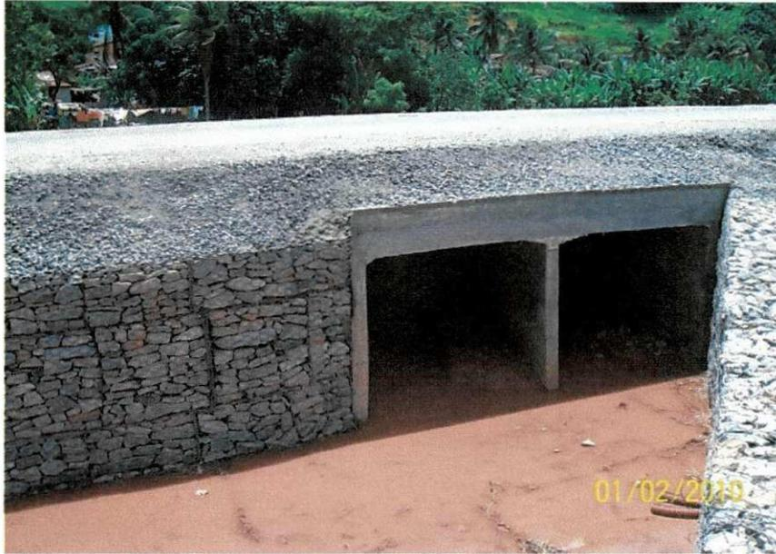
Figura 17: Detalhe de bueiro do tipo celular.
