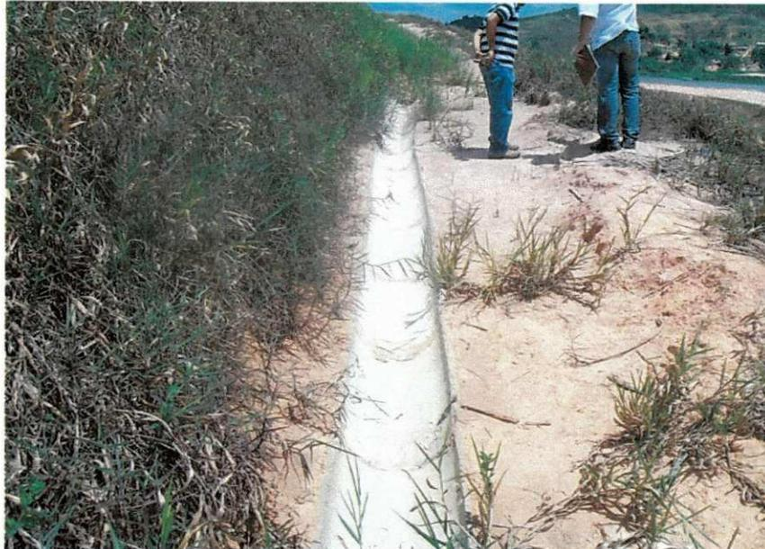
Figura 14: Valeta de proteção de corte tipo manilha.
